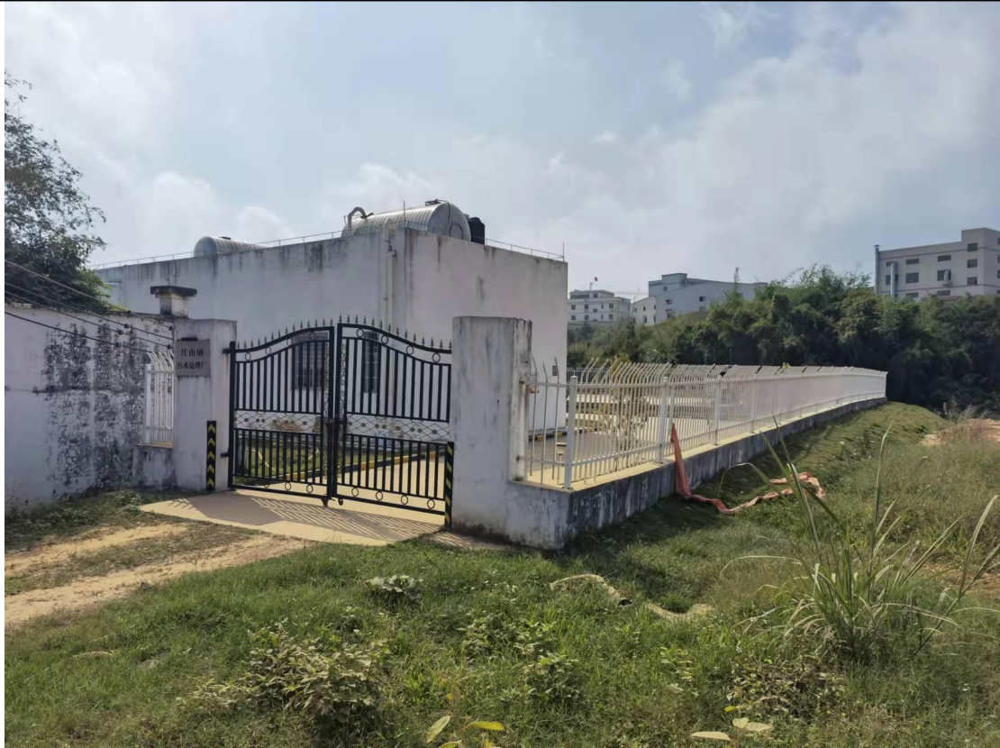
图 4-5 月山镇污水处理厂照片
