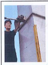
油烟废气 DA007 排放口
