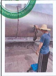
1#厂房硫化成型、脱模 废气 1#DA001处理前
