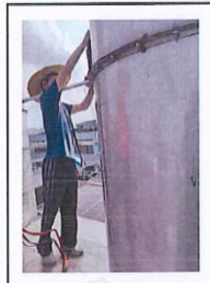
3#厂房投料、密炼、开 炼废气 DA006 排放口
