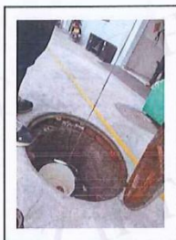
生活污水排放口
