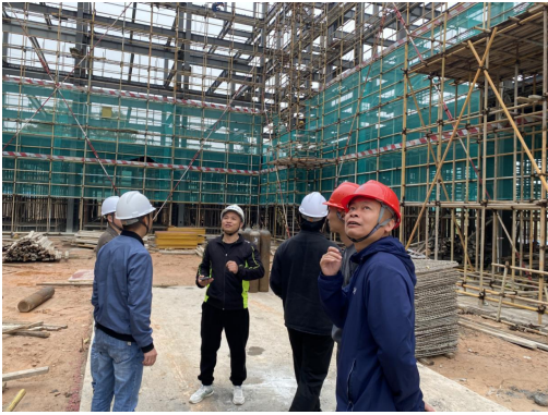
开平市住房和城乡建设局检查“迁建开平市特殊教育学校建设项目-门卫室、围墙；公共厕所；教学综合楼；配电房；垃圾房；功能楼、连廊”
