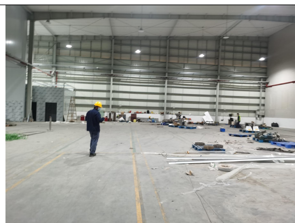
扩建项目所在车间
