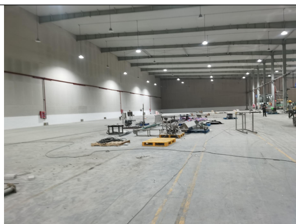
扩建项目所在车间
