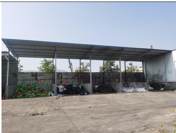
一般工业固体废物暂存处
