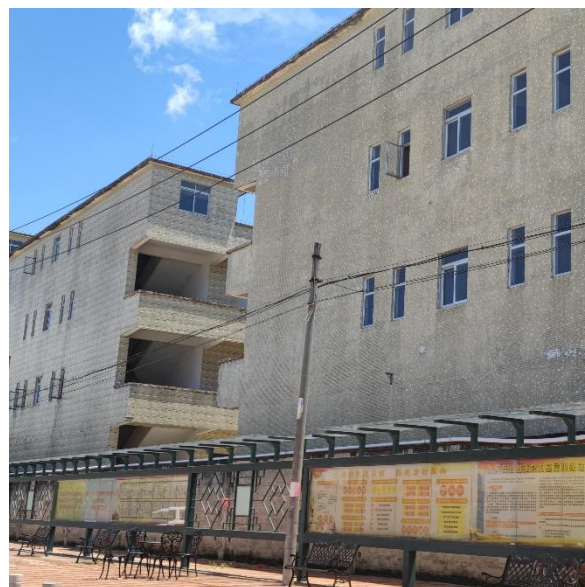
项目北面空置厂房
