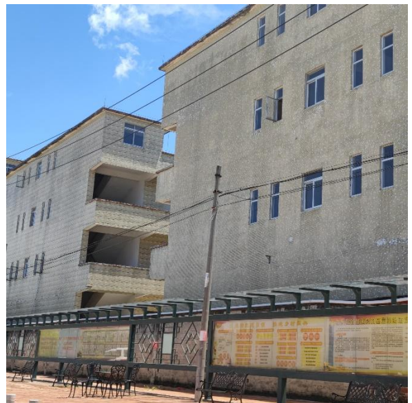
项目北面空置厂房
