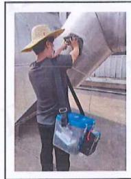
3#厂房硫化成型、脱模 废气 2#DA005处理前
