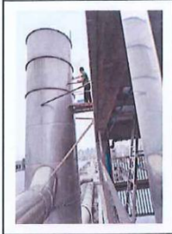
1#厂房硫化成型、脱模 废气 DA001排放口
