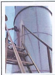
2#厂房硫化成型、脱模废气 DA002 排放口
