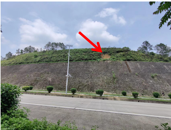
省道 274 线 K177+600 左幅路堑边坡水毁图片
