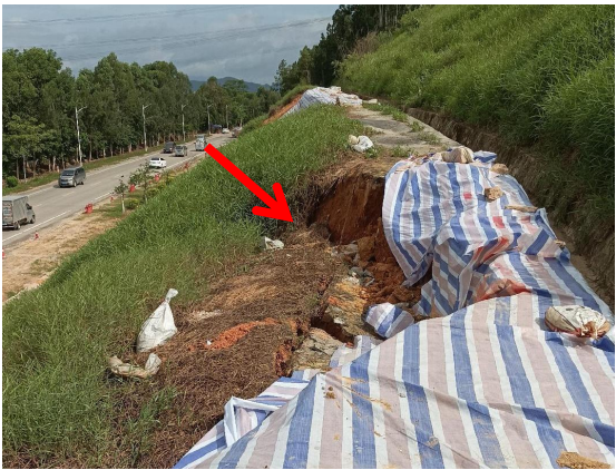
省道 273 线 K89+300 左幅路堑边坡水毁图片
