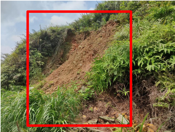
省道 274 线 K177+600 左幅路堑边坡水毁图片
