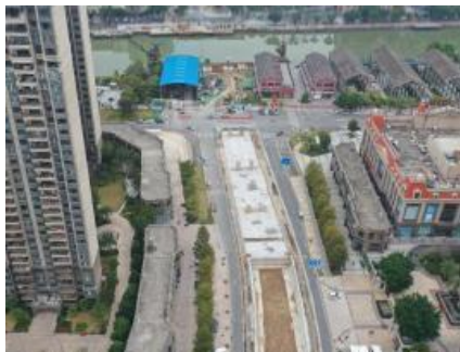
文昌路起点在建船厂跨江桥梁
