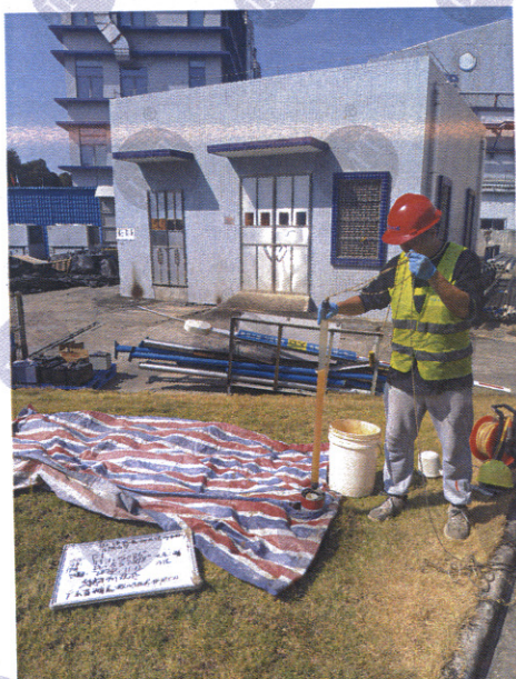
D1 H 罐区南面☆1#
