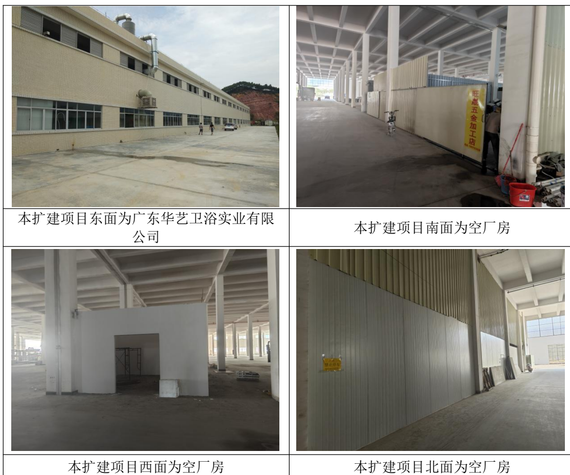
图 2-4 本扩建项目四至实景图
