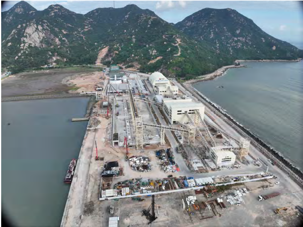
图 2.1.3-1 本项目后方矿石加工项目建设实景（拍摄时间 2024 年 10 月 14 日）
