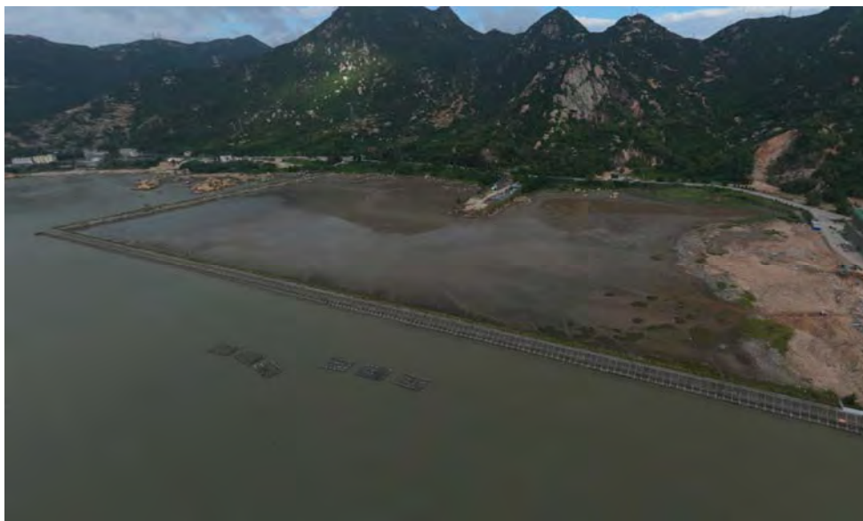
图 3.3.2-1 台山市广海湾鱼塘港物流区建设项目航拍图
