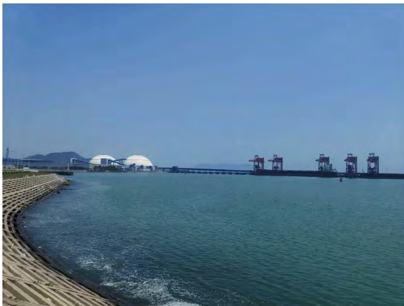
图 3.3.2-3 台山电厂 6、7 号机组“上大压小”扩建工程码头现场图片
