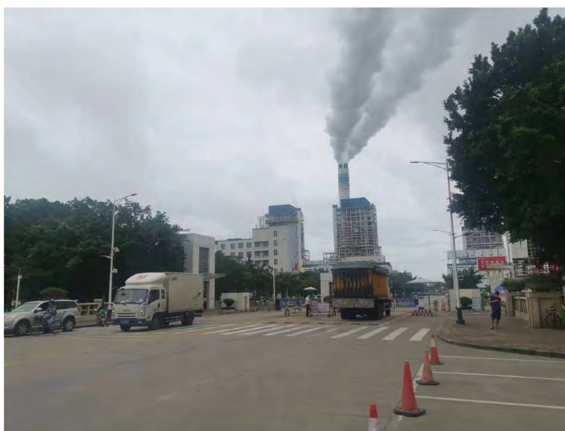
图 3.3.2-2 台山发电厂工程现场图片
