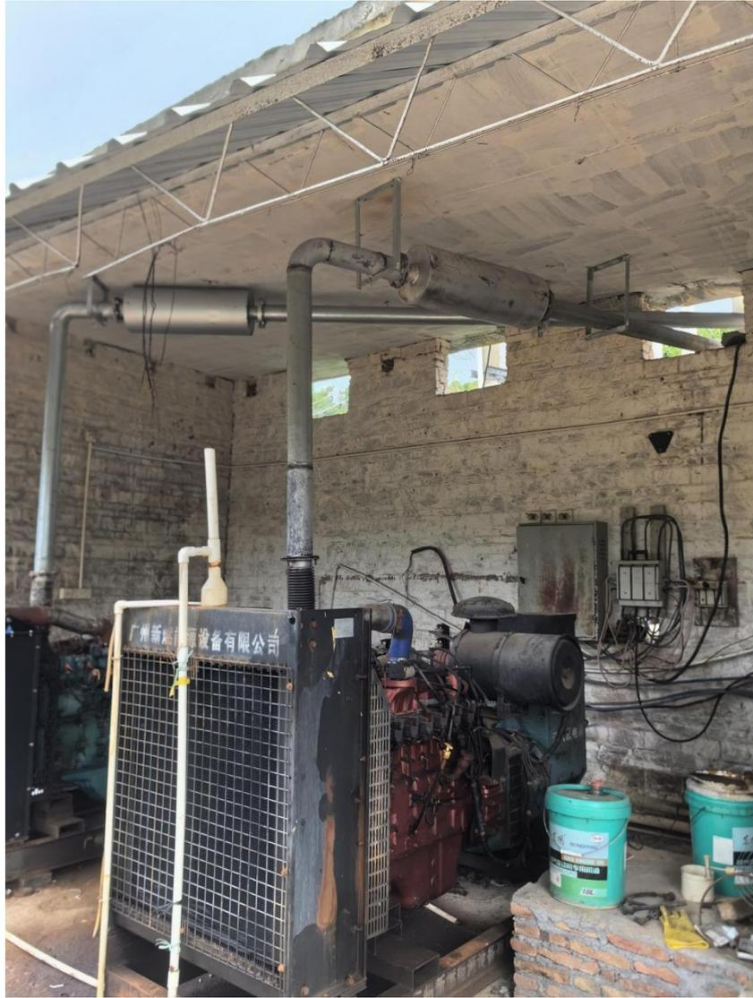
图 3.2-5 沼气发电机
