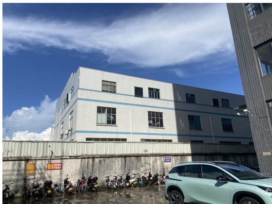
项目东面江门市浩一照明电器有限公司项目
