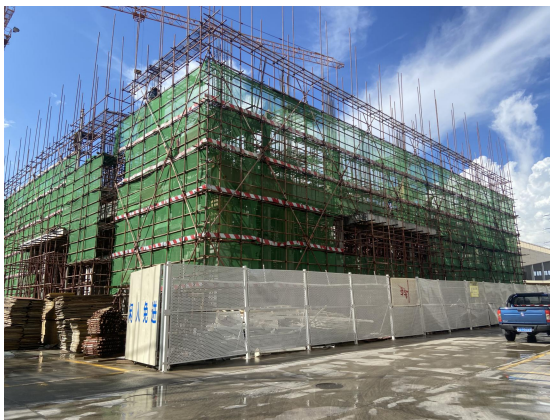
项目北面在建工地 附图 2 建设项目四至图
