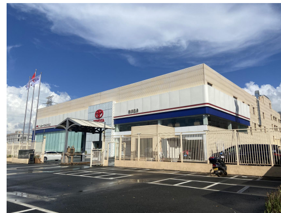
项目西北面江门市永佳丰田维修部
