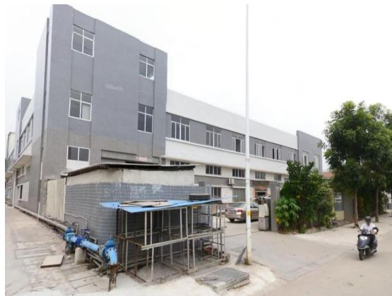
南面隔广珠城际铁路是江门市江海区宏特机械有限公司
