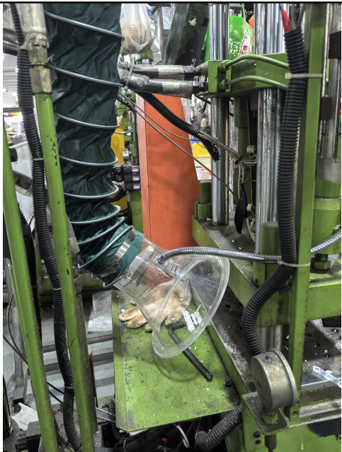
注塑废气收集方式照片
