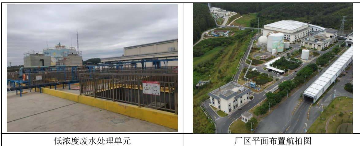
附图 4 项目现场照片
