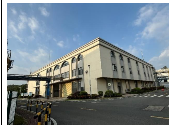
污泥干化处理车间
