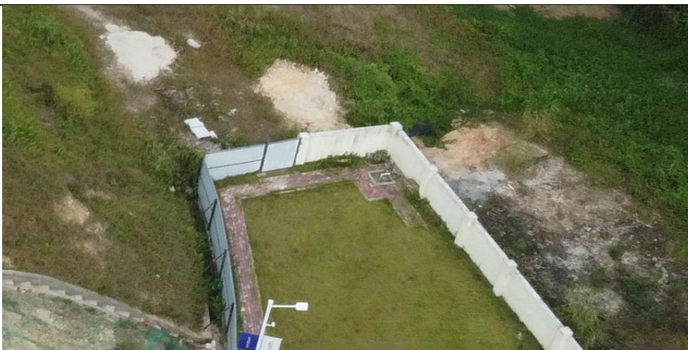
项目取水口航拍图
