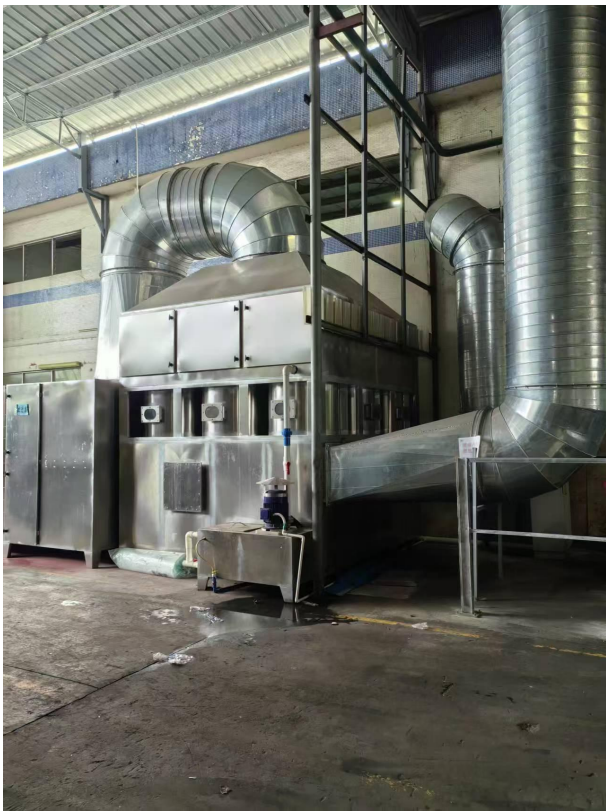
图 4-2 气旋喷淋塔+干式过滤器废气治理设施
