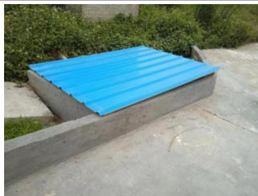
污水井加砌高再上盖，实现雨污分离
