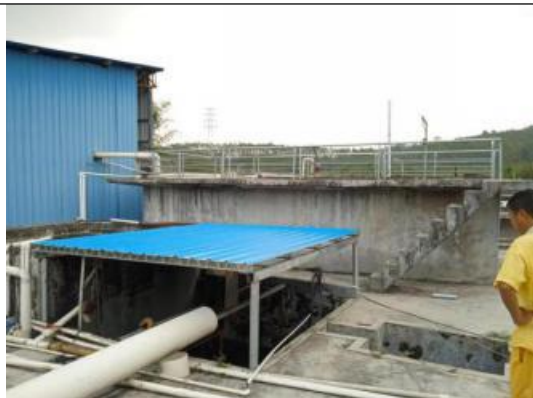
收集搅拌池防雨棚
