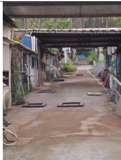
污水井盖周围砌筑挡水防止雨水流入污水井
