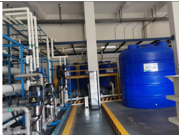
污水处理站膜处理车间
