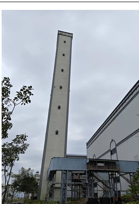
烟 80m 集束式排气筒（三管套筒）
