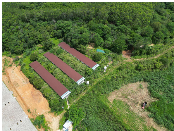
项目西北侧聚泉农业公司现状养殖场
