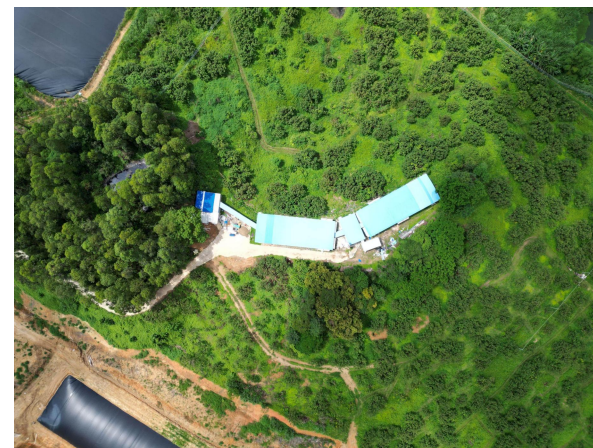
项目南侧建材堆场
