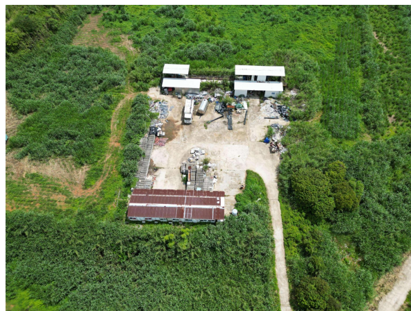
项目西北侧建材堆场
