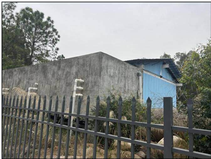
项目东面-广东科信新型装饰材料有限公司自建污水处理站
