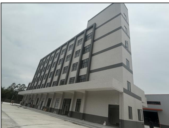
厂房及综合楼
