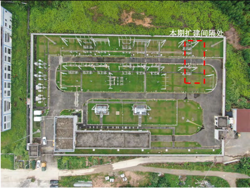
110kV 月山站航拍图
