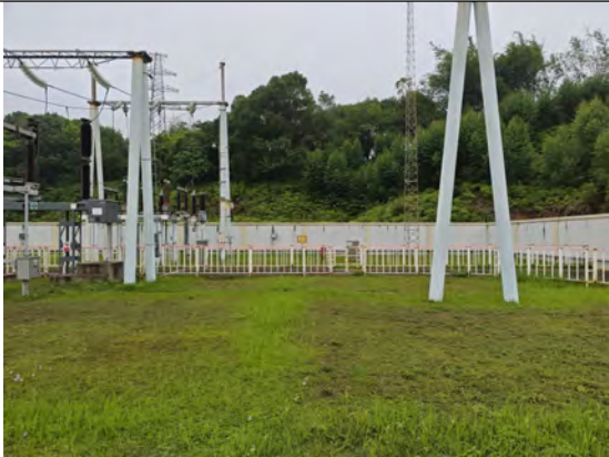
110kV 鹤南站间隔扩建处
