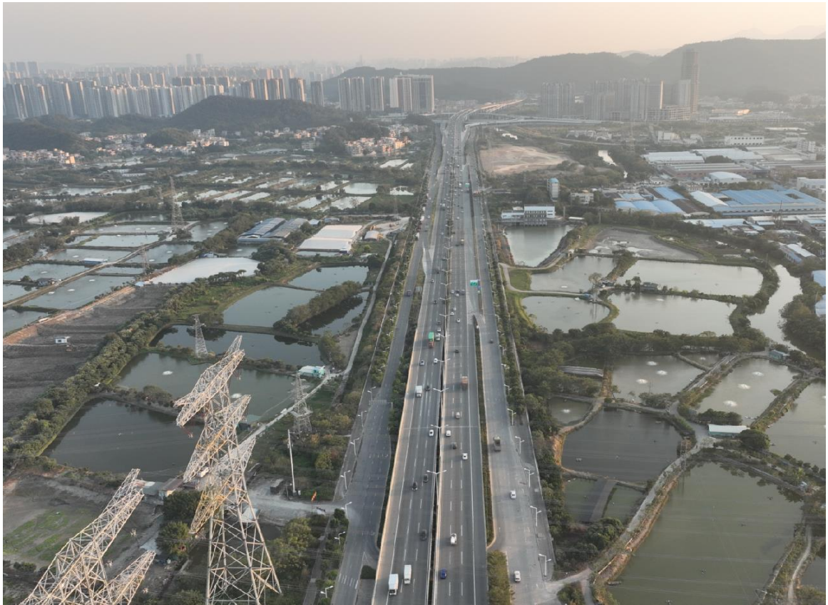
照片 5：五洞-西环路隧道段辅道工程（3）
