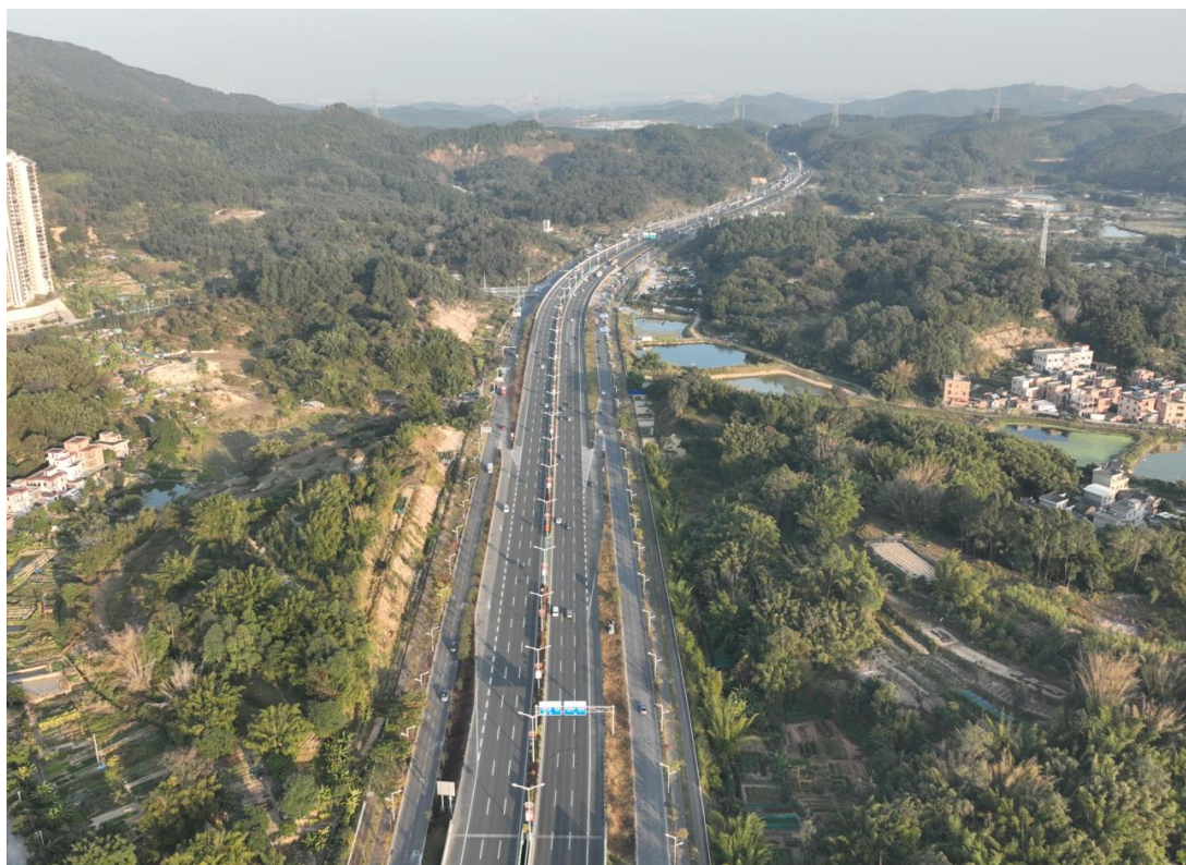
照片 1：鹤山段辅道工程（1）
