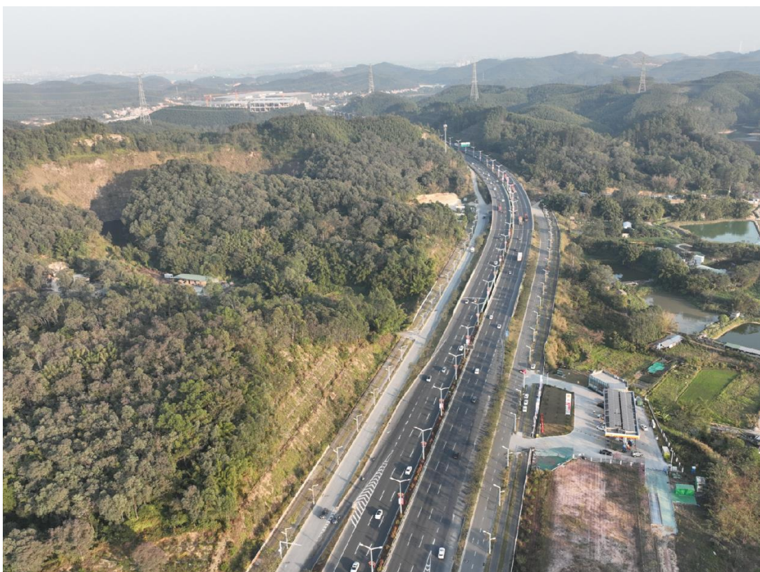
照片 2：鹤山段辅道工程（2）
