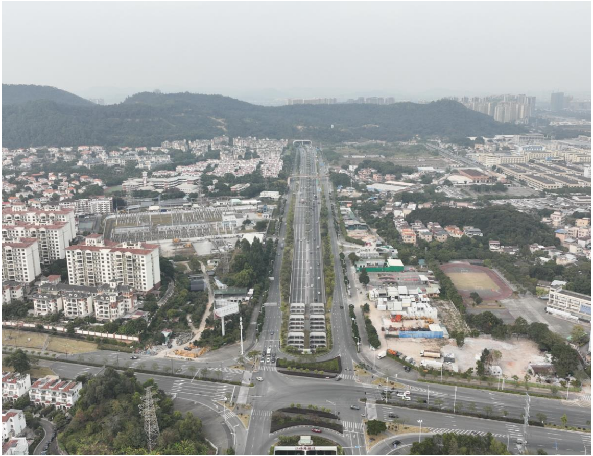
照片 7：西环路隧道-五邑路段辅道工程（1）
