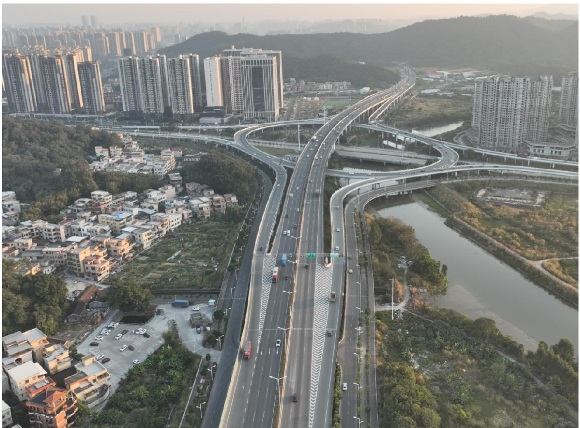
照片 6：五洞-西环路隧道段辅道工程（4）
