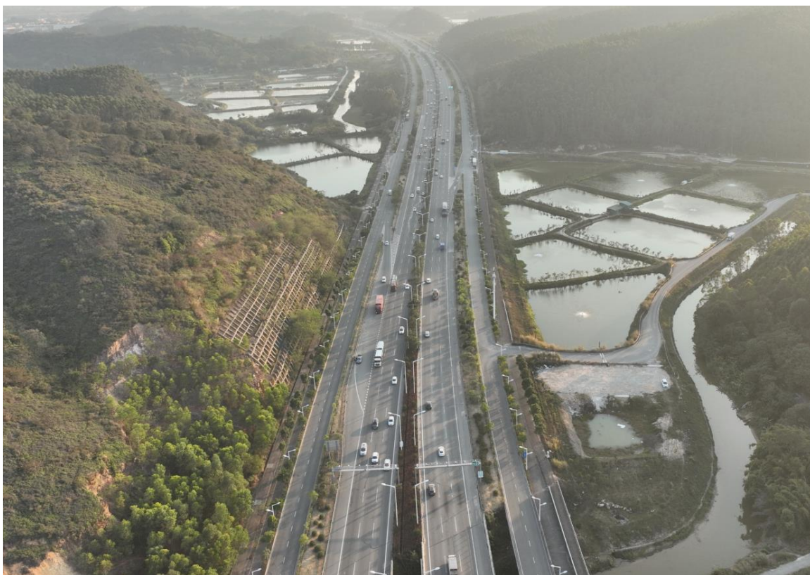
照片 3：五洞-西环路隧道段辅道工程（1）
