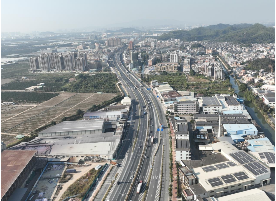
照片 9：新会段辅道工程（1）
