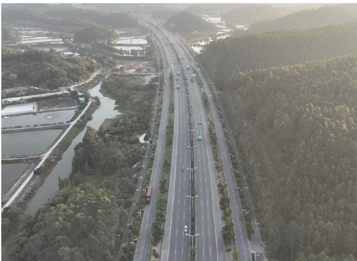
照片 4：五洞-西环路隧道段辅道工程（2）
