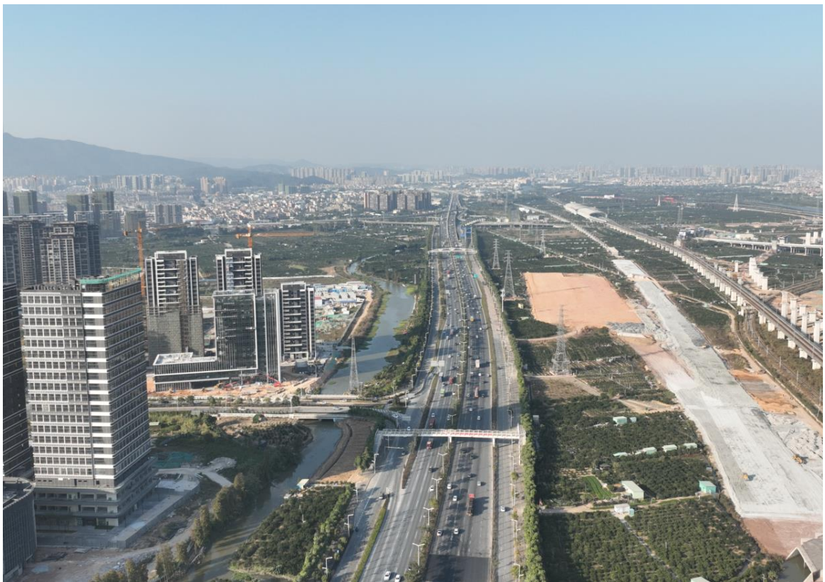
照片 10：新会段辅道工程（2）
