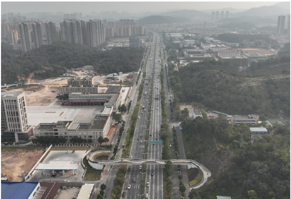
照片 8：西环路隧道-五邑路段辅道工程（2）
