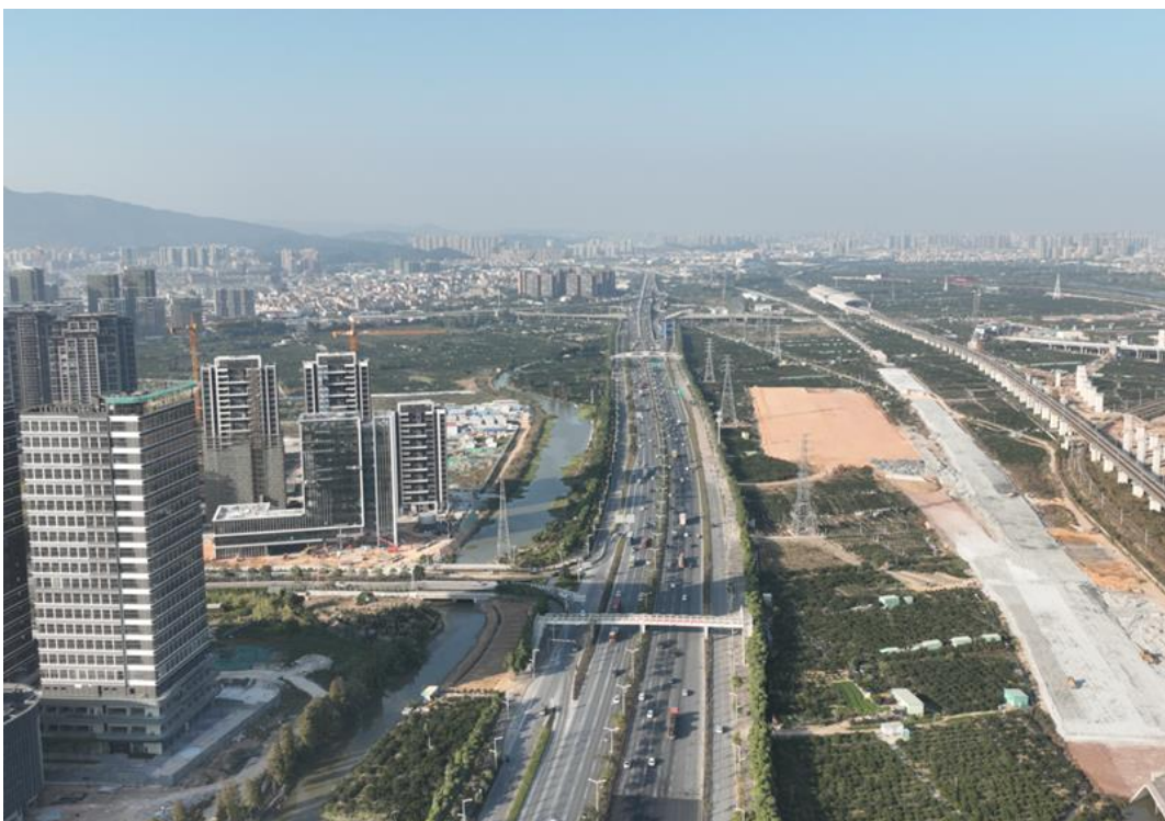
照片 10：新会段辅道工程（2）
