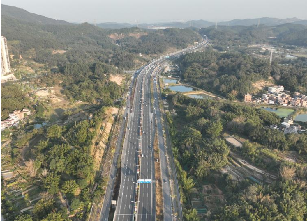
照片 1：鹤山段辅道工程（1）
