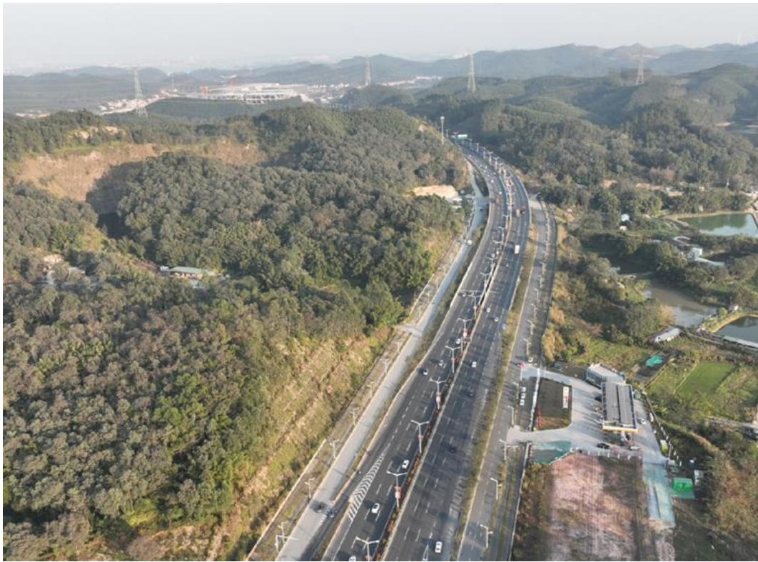
照片 2：鹤山段辅道工程（2）
