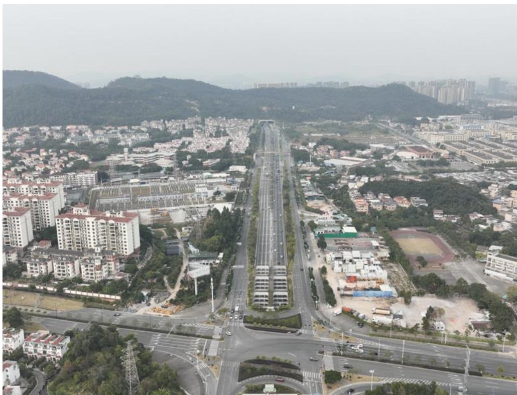
照片 7：西环路隧道-五邑路段辅道工程（1）
