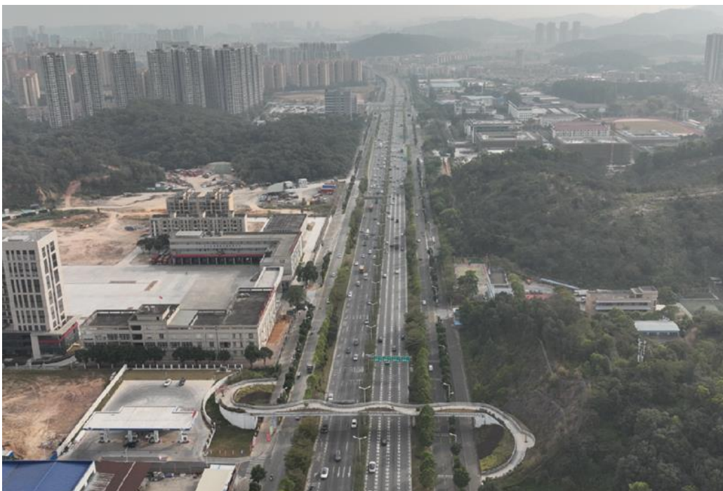
照片 8：西环路隧道-五邑路段辅道工程（2）
