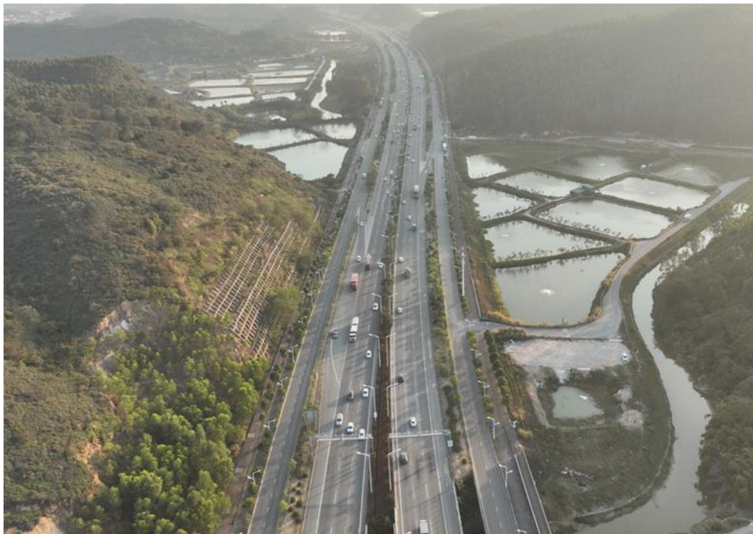
照片 3：五洞-西环路隧道段辅道工程（1）
