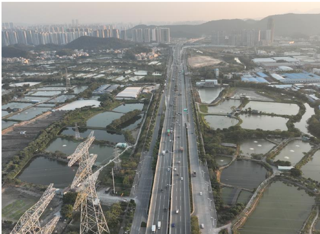
照片 5：五洞-西环路隧道段辅道工程（3）
