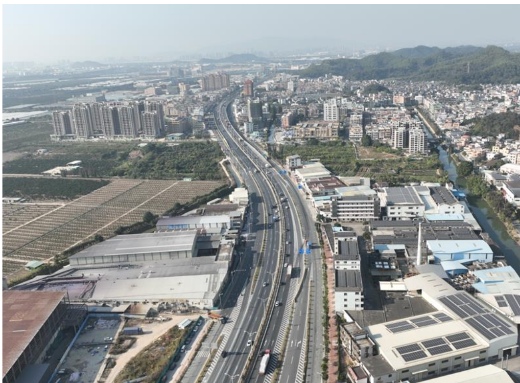
照片 9：新会段辅道工程（1）
