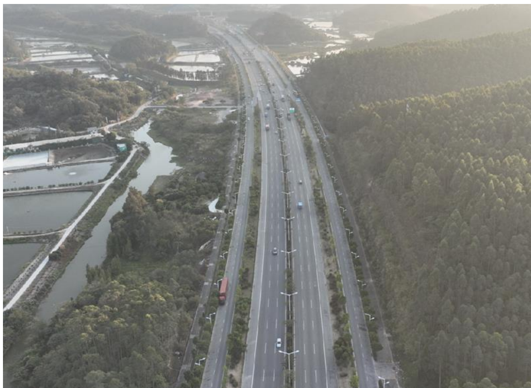
照片 4：五洞-西环路隧道段辅道工程（2）
