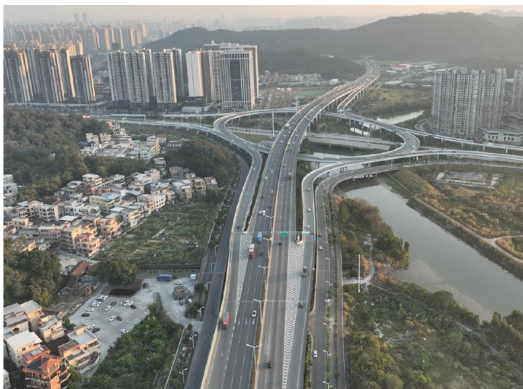
照片 6：五洞-西环路隧道段辅道工程（4）
