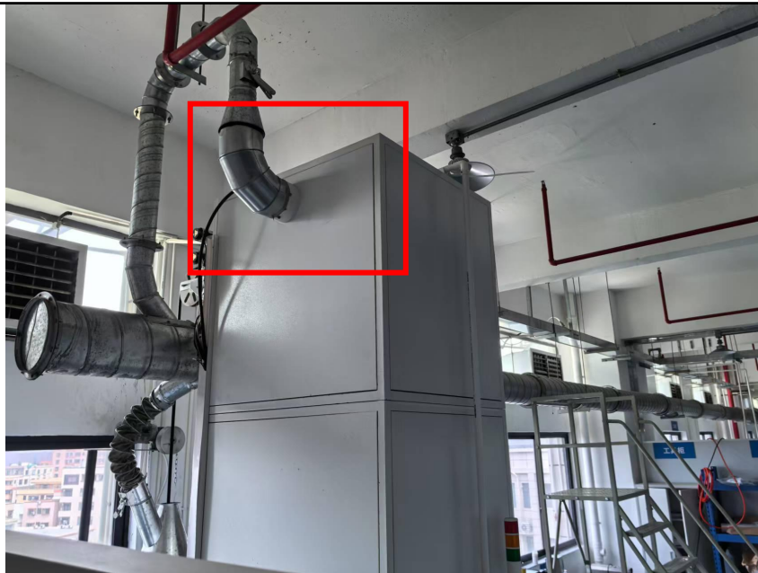
涂覆废气收集方式
