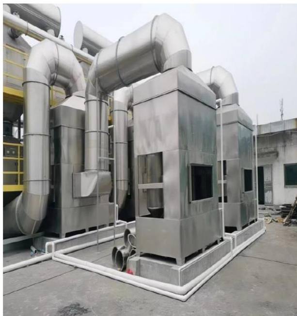
图7-4 气旋喷淋塔设备图
