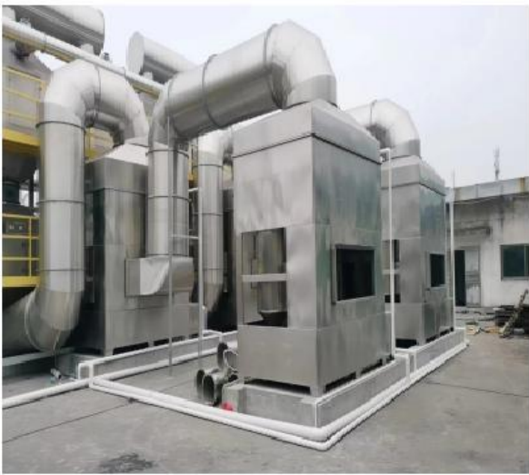
图7.4 水旋喷淋塔示意图
