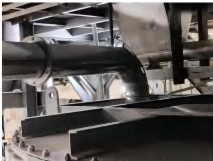
图 4.6-2 干燥废气收集方式示意图
