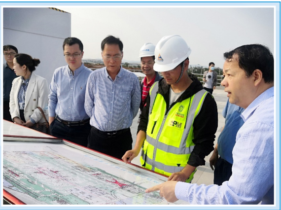
▲ 广州白云国际机场三期扩建工程水土保持检查
