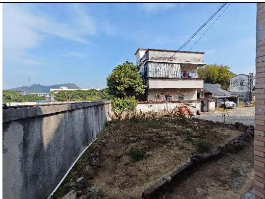
110kV 金鸡变电站厂界东南侧
