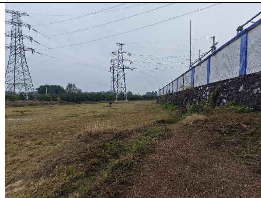
220kV 百合站厂界东侧
