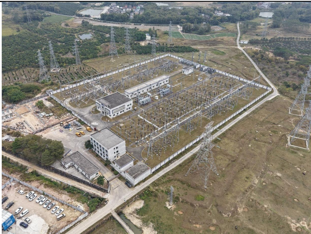
220kV 百合变电站厂界航拍图
