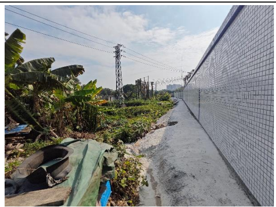
110kV 金鸡变电站厂界东北侧
