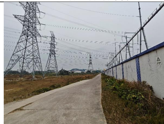
220kV 百合站厂界西侧
