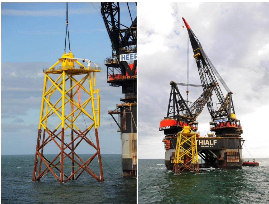
图 2.3.5-1 导管架切割之前准备工作示意图
