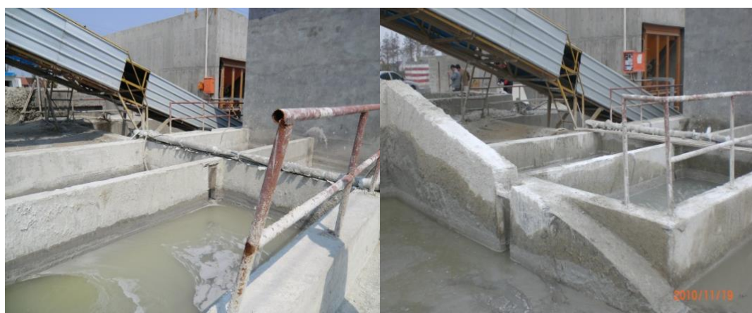
图 4.2-2 崇启大桥施工场地多级沉淀池
