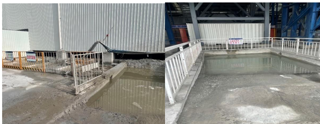
图 4.2-1 狮子洋通道施工标段多级沉淀池
