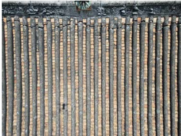
春阳堂轳筒裹灰瓦屋面断裂
