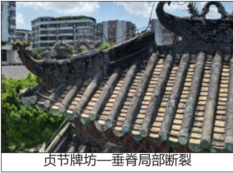
贞节牌坊—檐筒裹灰瓦面局部断裂
