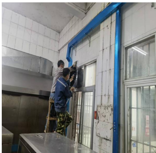
图 7-3 电灶线路改造
