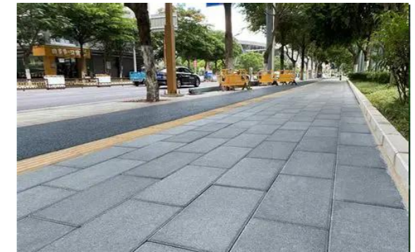
透水砖人行道铺装
