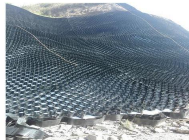
铺设完成的土工格室
