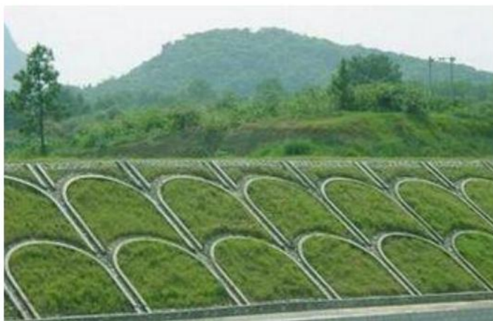
格构梁护坡绿化
