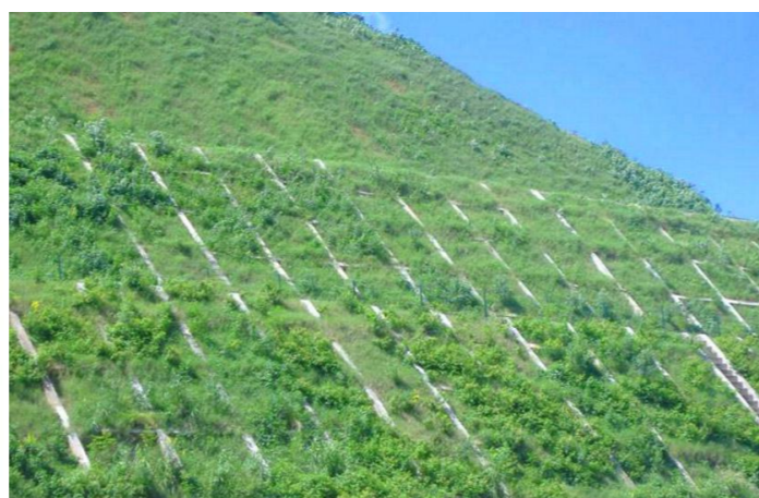
格构梁护坡绿化
