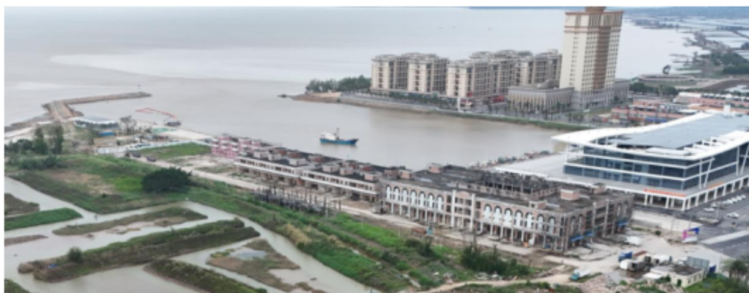
图 6.8.1-2 项目广海渔港（主港区）及周边土地利用现场照片
