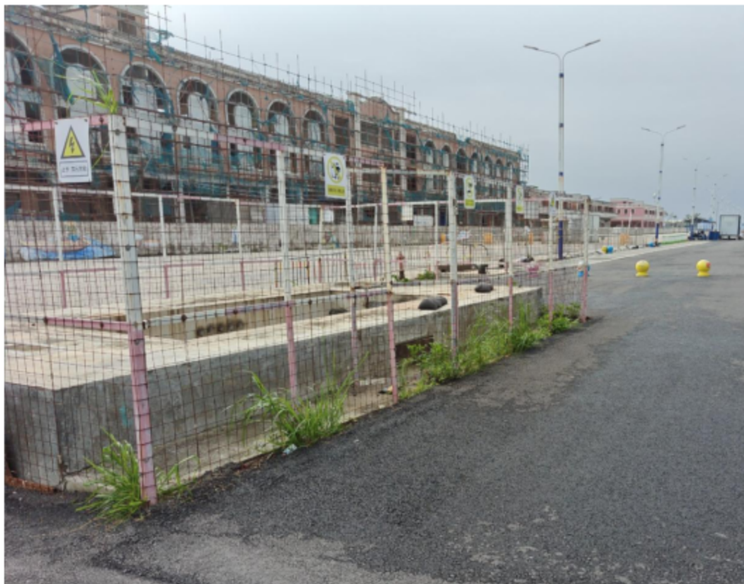
图 6.8.2-2 项目广海渔港（主港区）陆域用地范围植被现场照片
