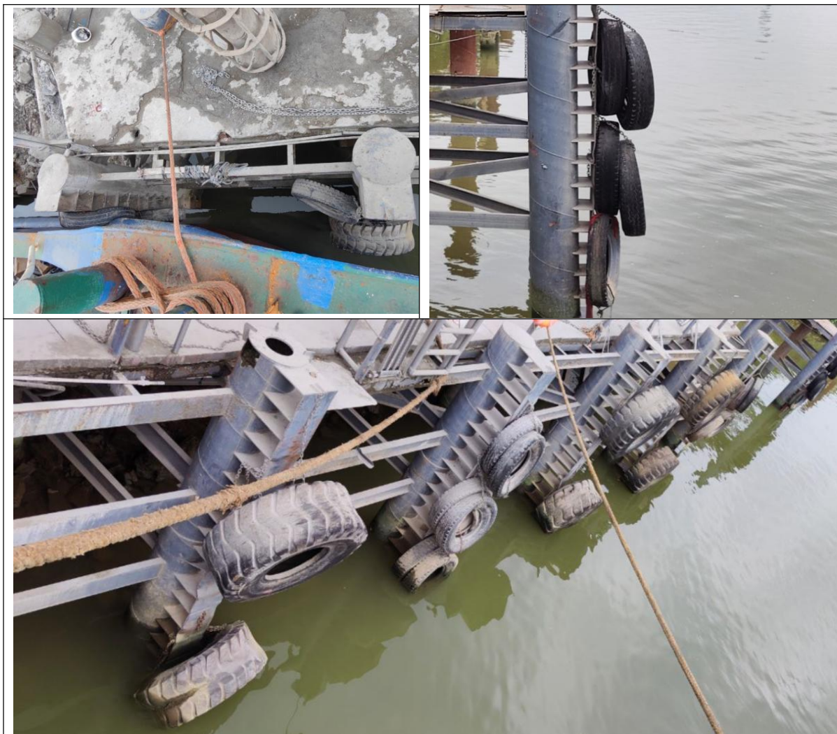
图 4.2.5.5-2 靠船设施现状照
