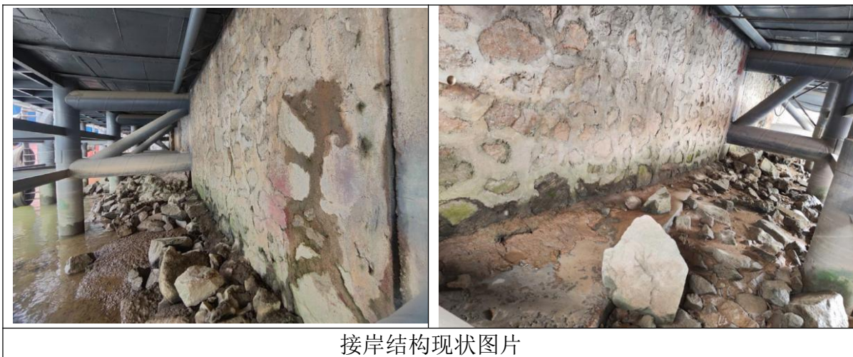
图 4.2.5.3-1 码头接岸结构现状图
