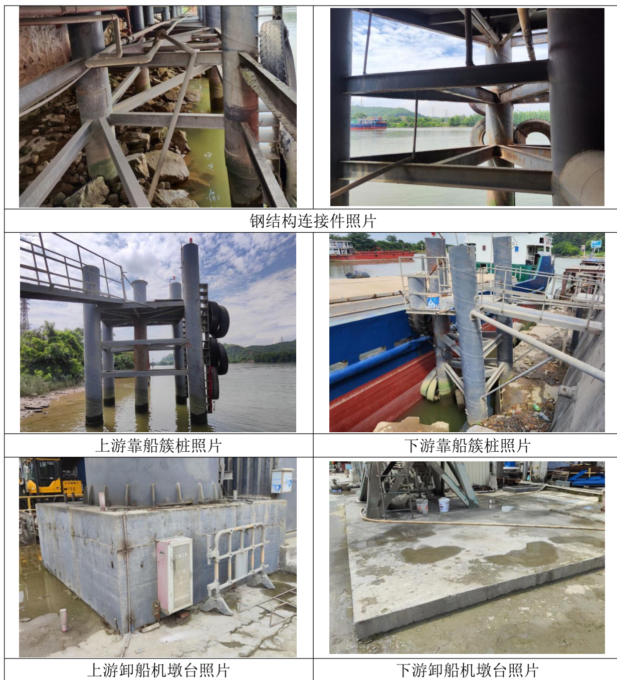
图 4.2.5.2-1 码头结构现状图
