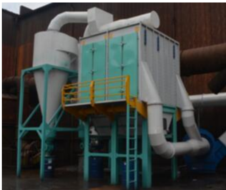
图 7.1-2 干法破碎分选废气处理系统设计示意图（旋风除尘+布袋除尘）
