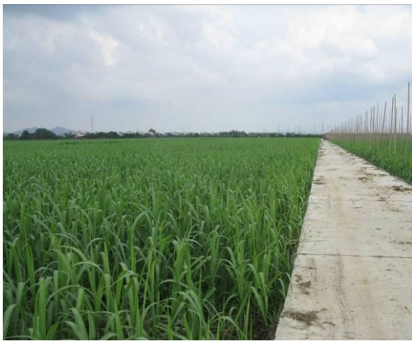
管道敷设后农田恢复现状
