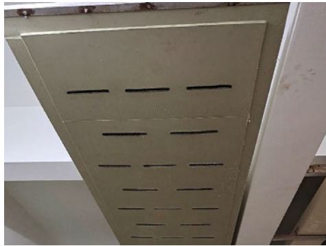
顶吸集气罩示意图
