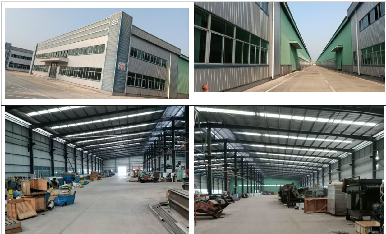
图 5.6-2 项目厂区硬化现状照片
