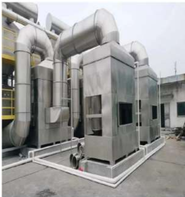
图8-2 气旋喷淋塔设备图
