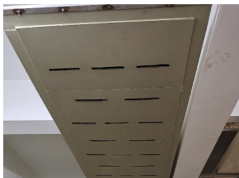
顶吸集气罩示意图
