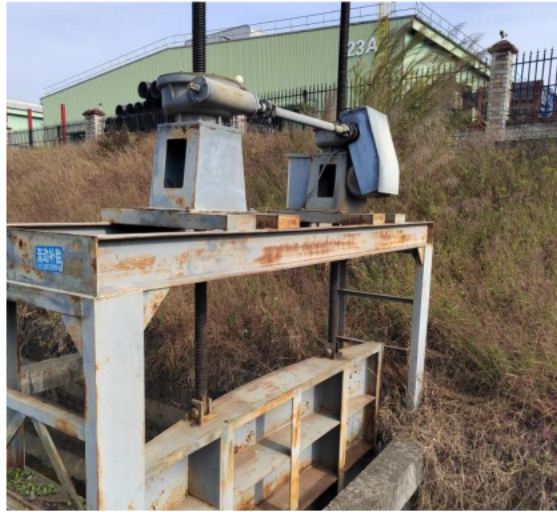
图 7.6-1 联塑工业园区雨水应急阀图
