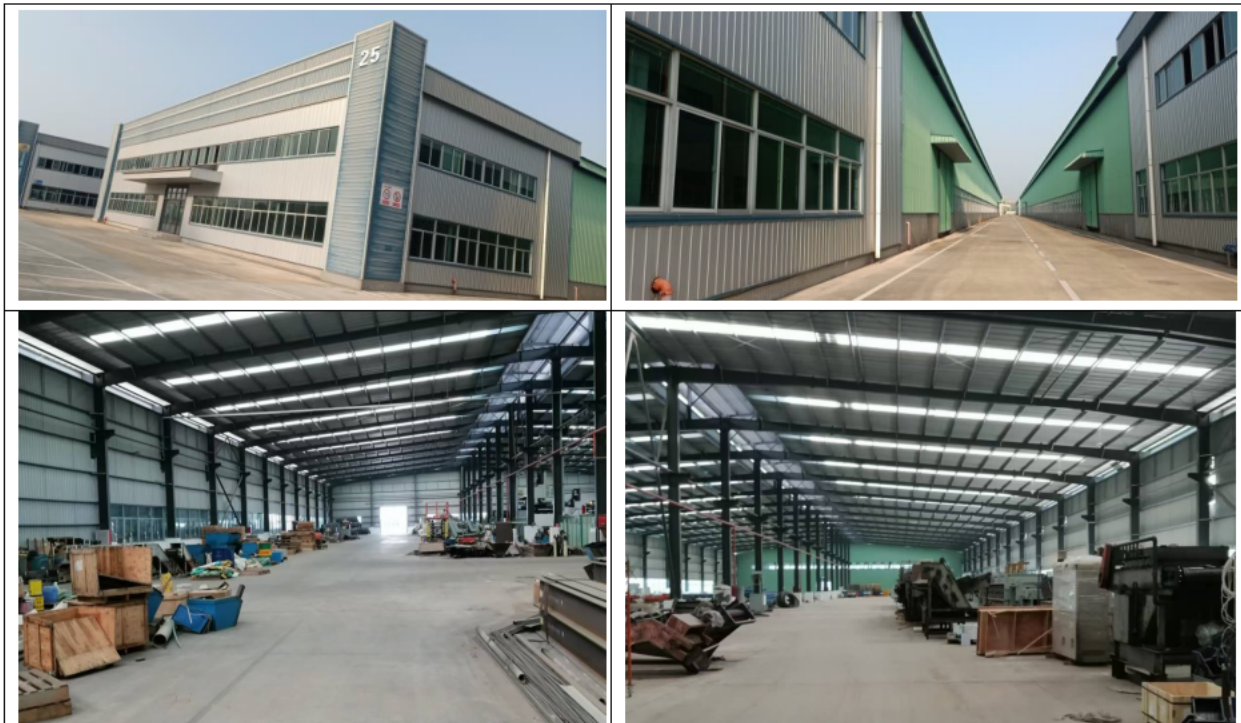
图 5.6-2 项目厂区硬化现状照片
