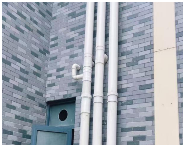
图4.1.3-2 【好】 卫生间沉箱设二次排水系统，周边顶板无渗漏
