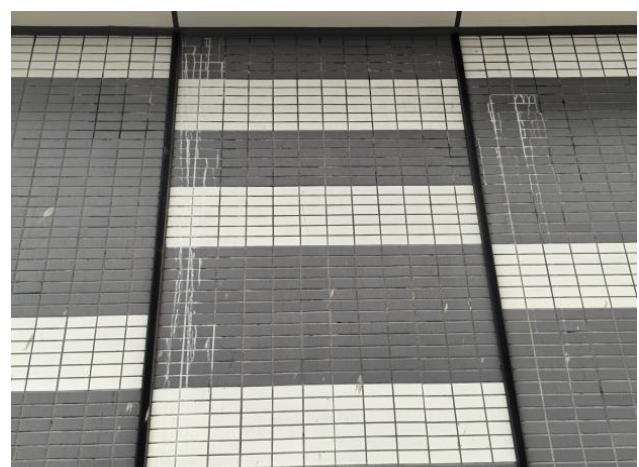
图1.1.4-2 【差】外墙饰面砖松动脱落、空鼓开裂
