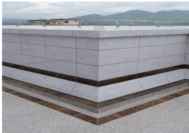
图1.4.6-2 【好】 屋面女儿墙泛水成型、精细美观无开裂渗漏
