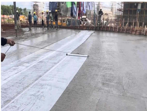
图1.3.2-1 【好】混凝土覆盖薄膜养护
