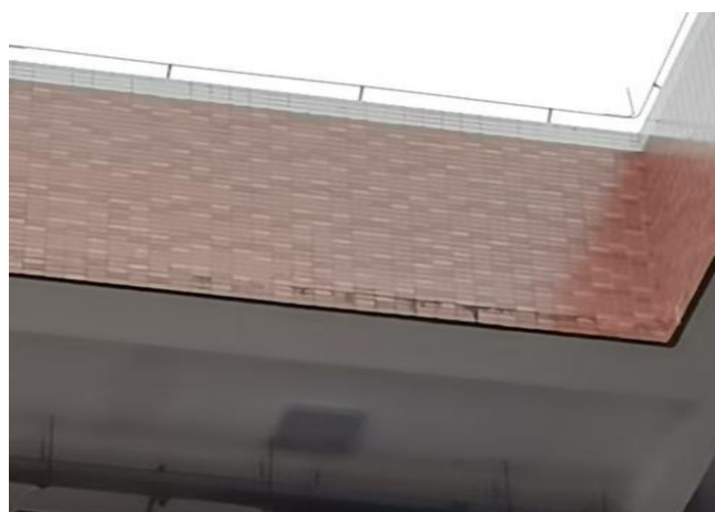
图1.4.6-3 【差】 屋面女儿墙根部渗漏
