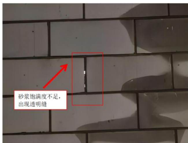
图2.1.3-6 【差】 砂浆饱满度不足，出现透明缝；水平灰缝不符合规范要求
