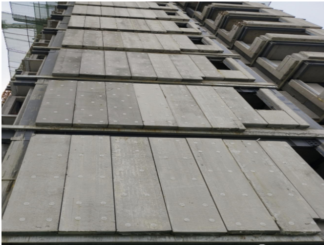
图1.1.6-2 【好】装配式外墙板接缝密封胶饱满，无渗漏
