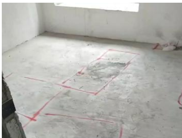
图5.2.1-2 【差】隔声砂浆空鼓、开裂
