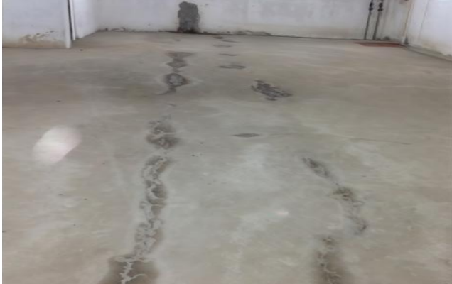
1.5.3-2 【差】 地下室后浇带未清理干净有积水、地下室后浇带施工缝处开裂、渗漏
