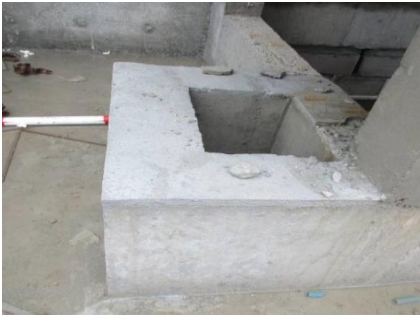
图1.4.3-1 【好】出屋面烟道混凝土反坎随屋面板一次浇筑成型
