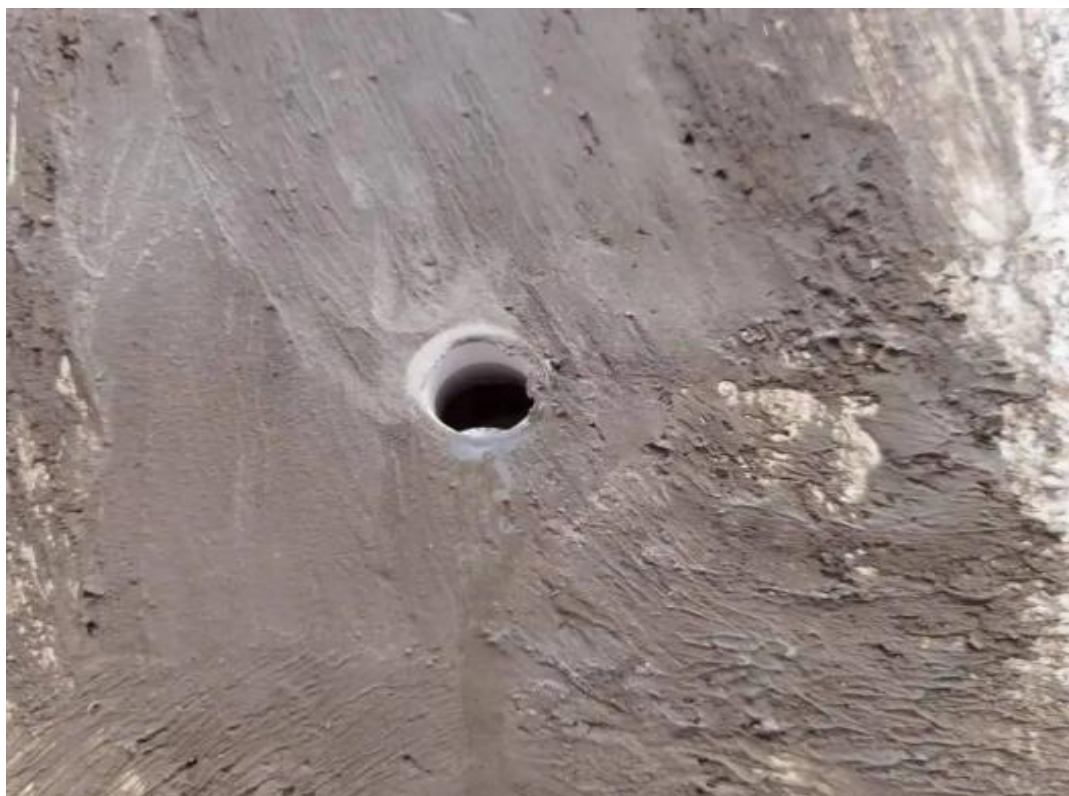
图4. 2. 4-3 【差】装修阶段半成品保护不到位导致地漏预留管堵塞
