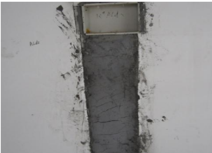
图2.3.5-2 【差】 管线槽处抹灰无挂网、开裂
