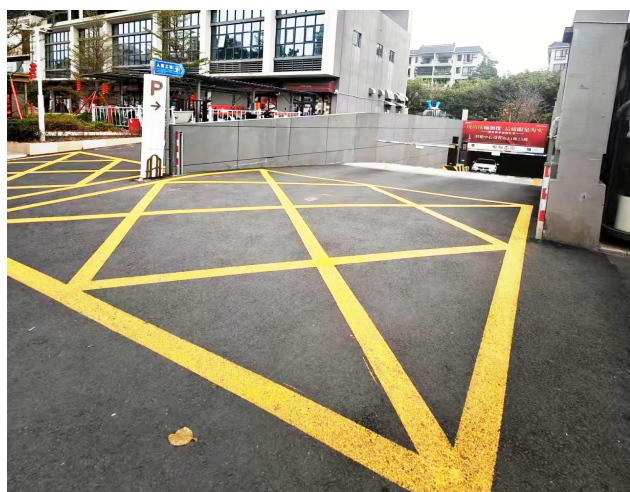
图1.5.5-2 【差】 坡道入口无反坡、截水沟位置错误、雨水倒灌地下车库
