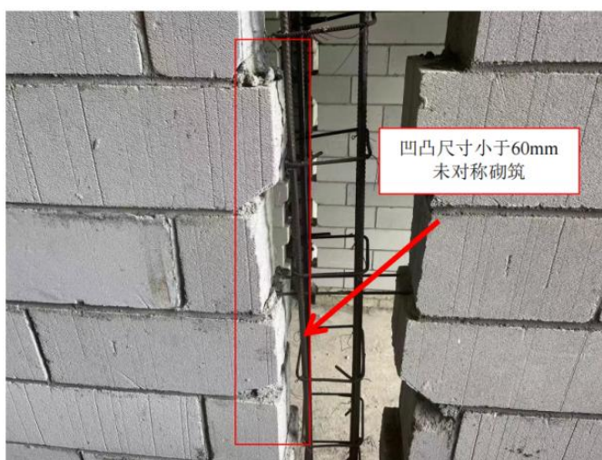
图2.1.3-5 【差】 凹凸尺寸小于60mm未对称砌筑；未按要求设置构造柱
