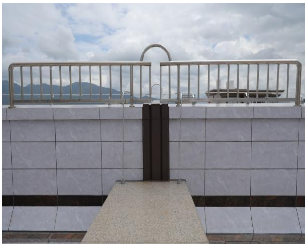
图1.4.5-1 【好】屋面变形缝防水 施工规范
