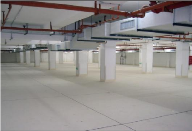
图2.2.4-1 【好】大面积混凝土地面合理分缝避免地面收缩开裂
