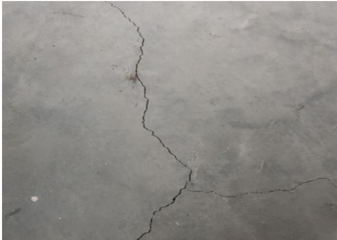
图2.2.5-2 【差】 室内楼地面开裂
