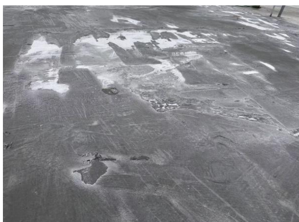
图1.4.2-4 【好】涂膜防水施工规范， 涂膜厚度符合要求，观感效果好
