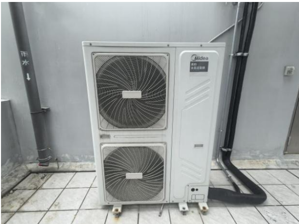
图5. 4. 1-3 【差】空调室外机未固定
