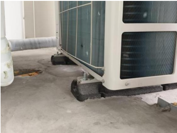
图5. 4. 1-1 【好】空调外机安装成品减振垫
