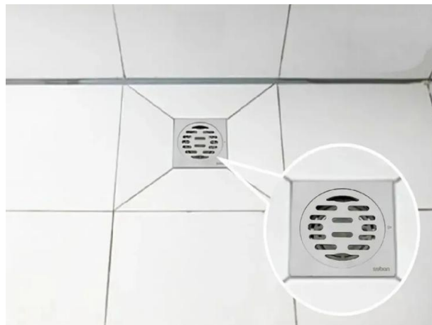
图3.1.2-1 【好】 地漏安装精细，存水弯有效隔断臭味
