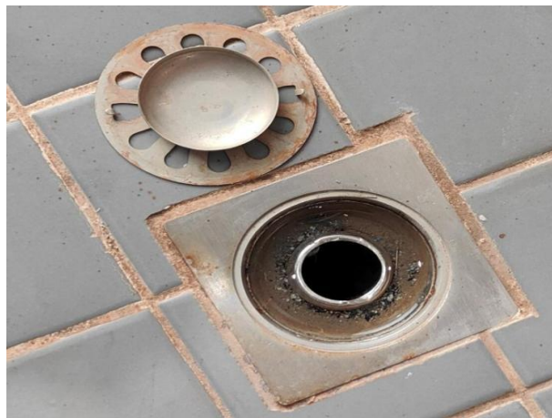
图3.1.2-4 【差】 使用钟罩式结构地漏，水封易失效，异味反窜入室内
