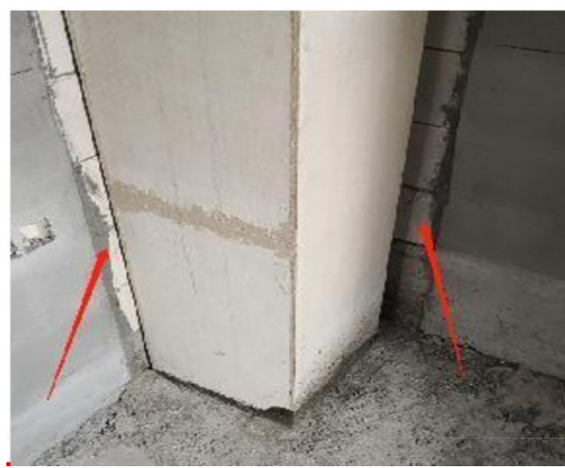
图3.2.1-6 【差】 排烟道两侧墙体未抹灰、接缝未挂网抹灰
