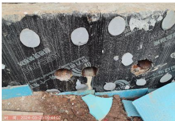
图1.5.2-8 【差】防水卷材未卷入预埋套管内，防水保护不到位、侧壁穿墙管道渗漏水
