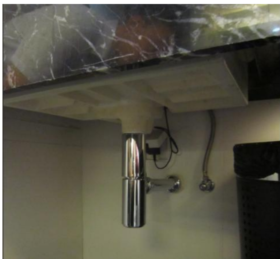
图4.1.2-1 【好】 排水水封带检修功能，方便检修
