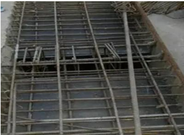
图2.2.2-1 【好】后浇带采用独立格构柱支撑体系
