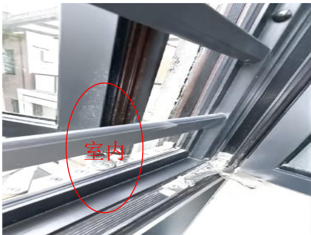
图1.2.1-7 【差】铝合金窗型材接口拼缝不严密、窗框四周塞缝不严密，渗漏
