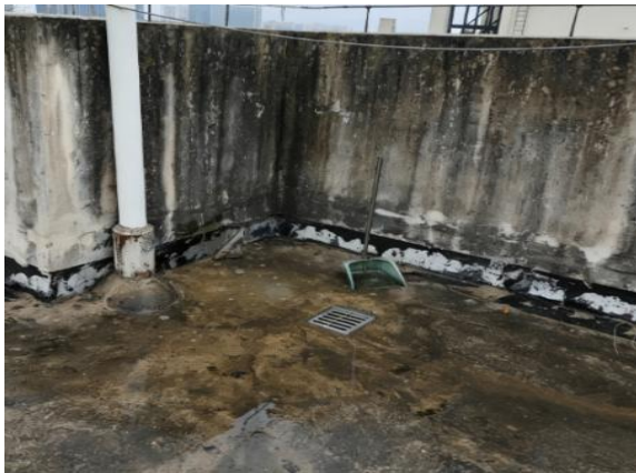
图4.2.3-4 【差】雨水斗坡度设置不合理，排水不顺
