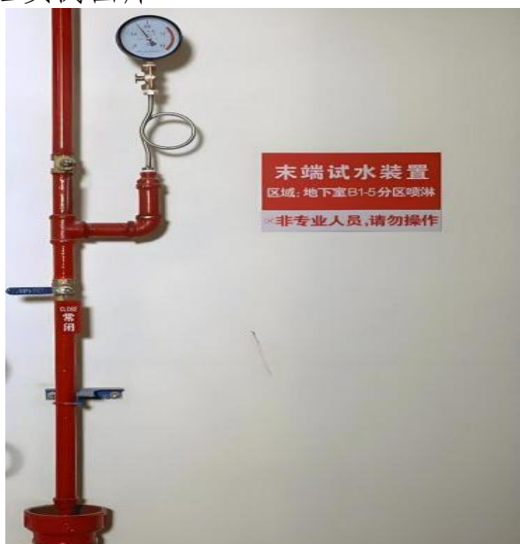
图4.1.4-1 【好】 喷淋试水装置规范设置
