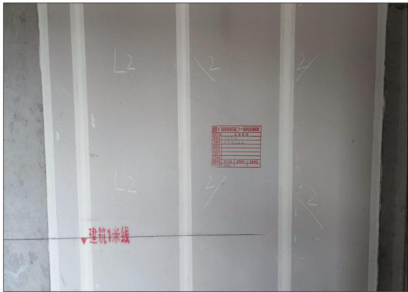
图2.1.5-1 【好】 ALC墙板成型质量观感良好；墙板交接处挂网补缝、成型效果平整、无开裂
