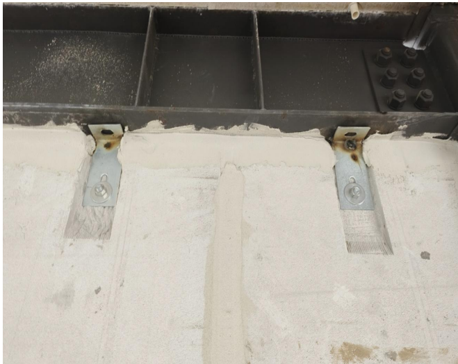
图1.1.6-3 【差】外墙墙板拼缝处渗漏、与钢梁连接处渗漏
