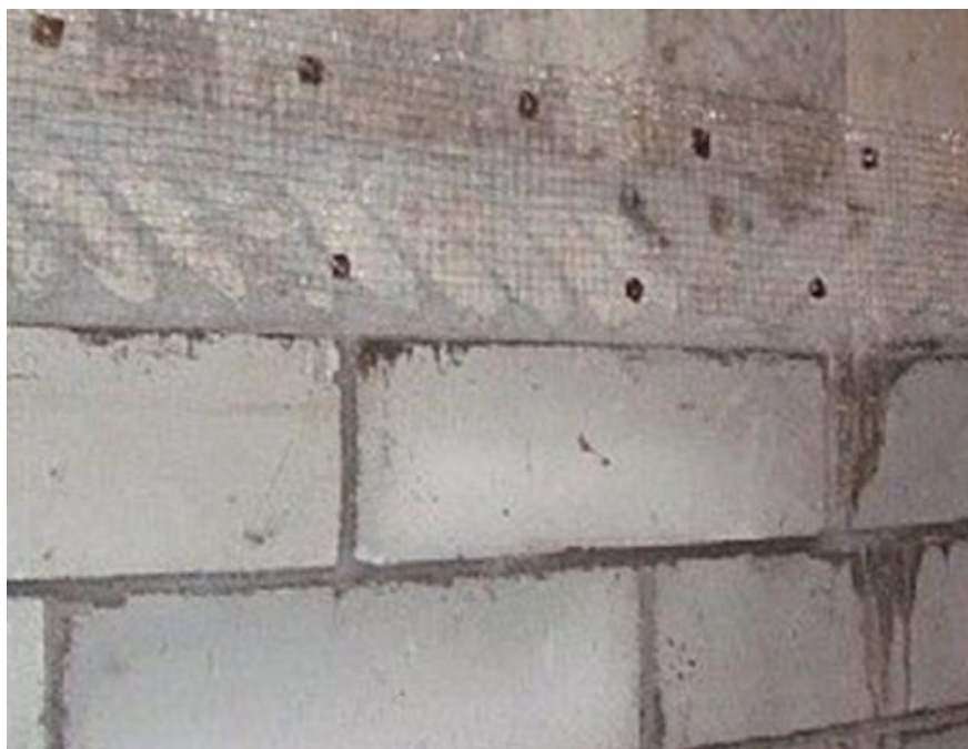
图2.3.4-1 【好】 顶砌交接处挂网照片
