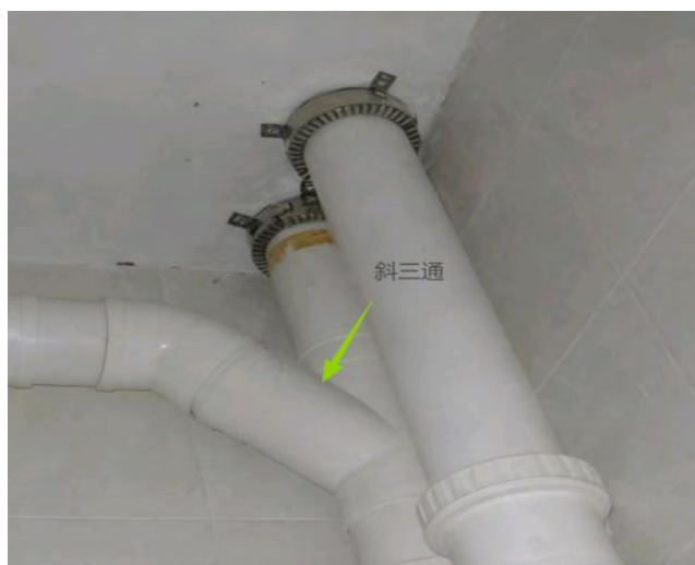
图3.1.1-1 【好】 立管与横干管采用45°三通连接
