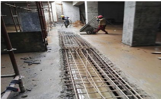
1.5.3-2 【差】 地下室后浇带未清理干净有积水、地下室后浇带施工缝处开裂、渗漏
