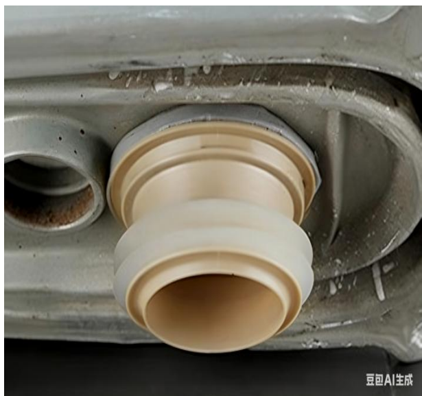
图3.1.4-1 【好】 坐便器底座排污口采用一体化加长法兰，底座与地面打防霉密封处理
