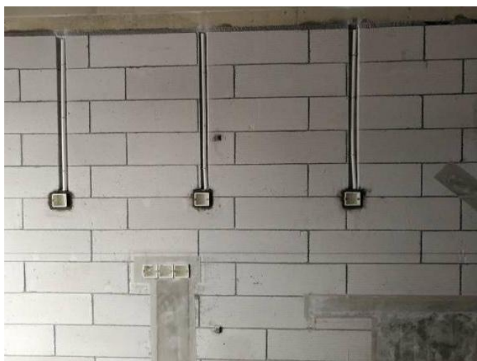
图2.1.6-1 【好】 采用专用开槽机具开槽，成型效果良好；强弱电箱和消防箱ALC墙板预先埋设
