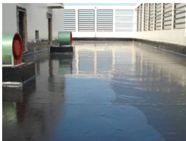
图1.4.2-4 【好】涂膜防水施工规范， 涂膜厚度符合要求，观感效果好
