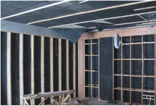
图5.2.2-1 【好】吊顶有填充隔声毡、隔声垫等加强隔声措施
