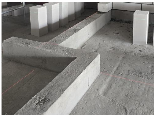
图1. 3. 5-1 【好】厨卫间反坎浇筑成型效果好
