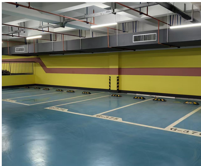
图1.5.2-4 【好】 地下室侧墙无渗漏，油漆面光滑无起皮、脱落
