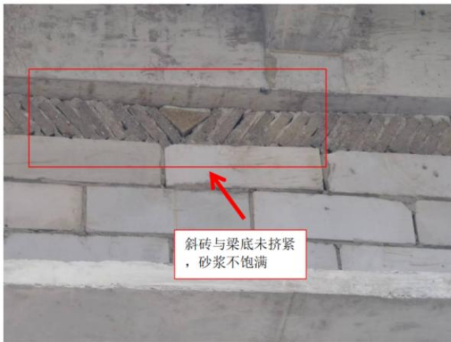
图2.1.2-3 【差】 砌体墙与结构梁交界斜砖未挤紧，砂浆不饱满；砌体墙与梁结构灌缝不密实
