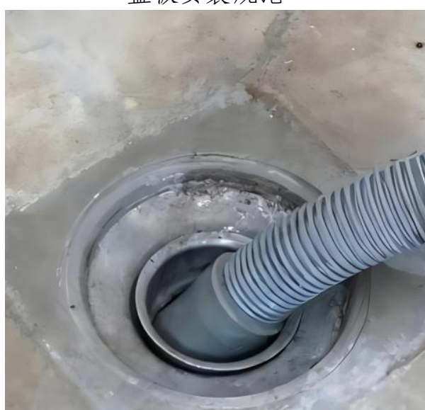
图4.2.2-2 【好】阳台洗衣机地漏盖板安装规范
