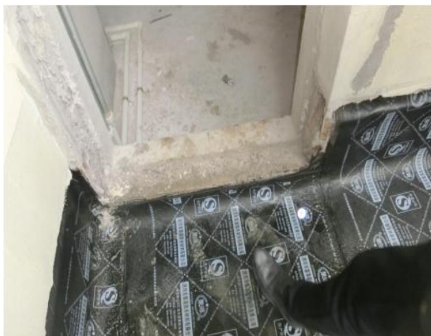
图1.4.7-3 【差】 屋面出入口防水卷材施工不规范
