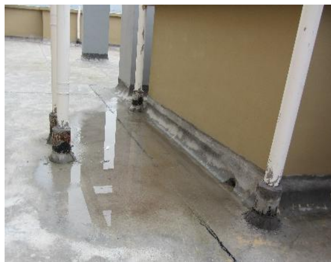
图4.1.5-4 【差】 侧排地漏坡度不足，积水明显
