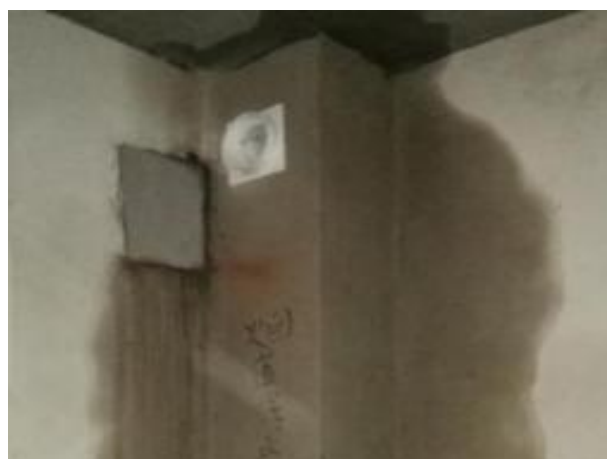
图1.3.2-4 【差】排气道根部与地面、墙体交接处渗漏
