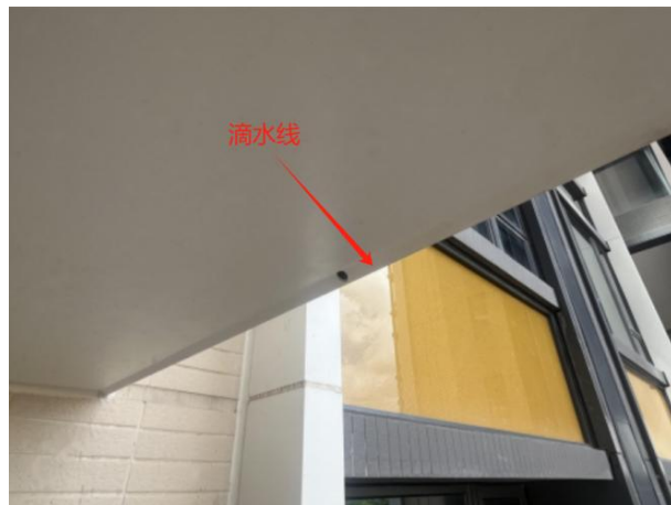
图1.1.7-2 【好】门窗上楣的外口做滴水线槽或鹰嘴向外找坡不小于5%
