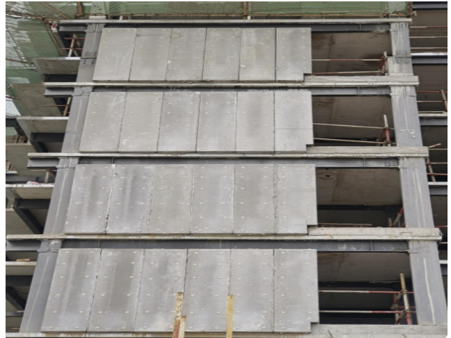
图1.1.6-2 【好】装配式外墙板接缝密封胶饱满，无渗漏
