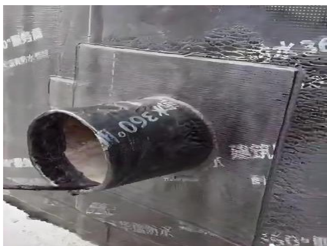
图1.5.2-5 【好】 穿墙套管防水附加层以及防水卷材卷入预埋套管内50mm、穿墙群管封堵密实，无开裂、无渗漏
