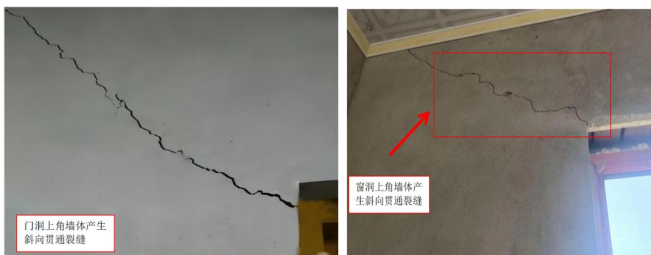
图2.1.4-2 【差】 门洞上角墙体产生斜向贯通裂缝；窗洞上角墙体产生斜向贯通裂缝
