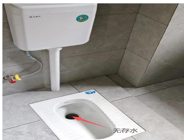
图3.1.3-2 【差】 蹲便器存水弯安装不正确/池体无存水持续散发臭味
