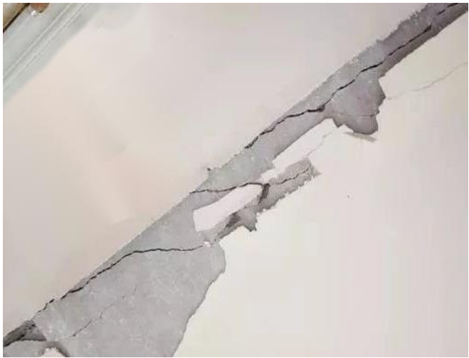
图2.3.3-2 【差】天棚抹灰层大面积开裂、脱落
