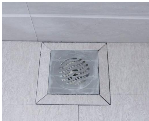
图4.2.1-2 【好】 厕浴地漏毛发过滤网及盖板定期清理
