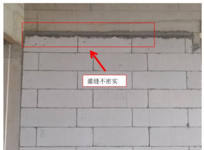
图2.1.2-3 【差】 砌体墙与结构梁交界斜砖未挤紧，砂浆不饱满；砌体墙与梁结构灌缝不密实
