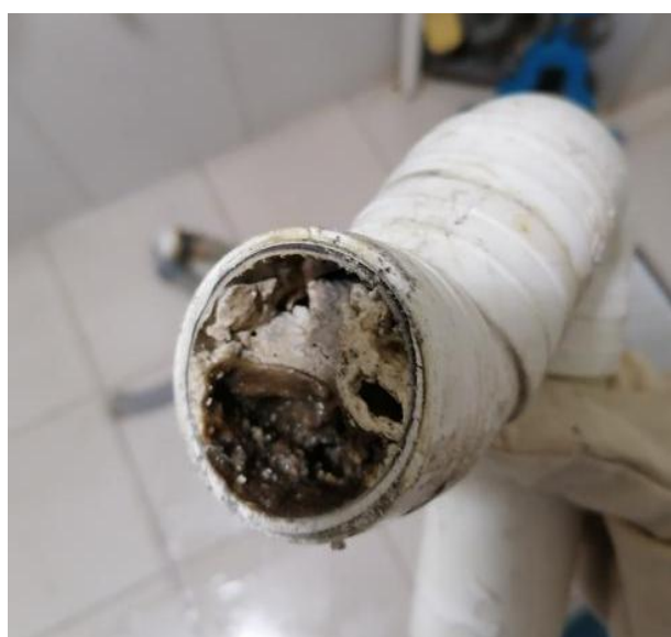
图4.2.2-3 【差】阳台地漏存水弯杂物堆积堵塞
