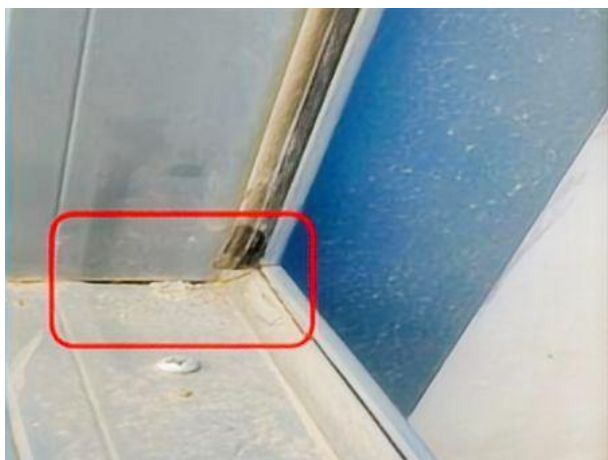
图1.2.2-7 【差】幕墙开启扇密封条性能差，不密闭
