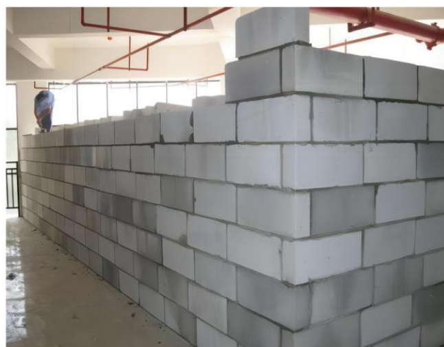
图2.1.3-5 【差】 凹凸尺寸小于60mm未对称砌筑；未按要求设置构造柱
