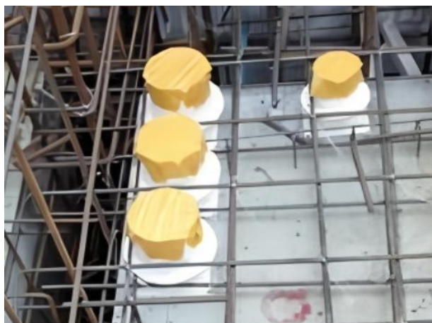
图1. 3. 3-1 【好】厨卫间排水止水节预埋安装定位精准及管道周边防水做法标准
