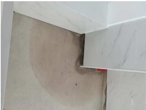
图1.4.3-2 【好】烟道根部防水附加层处理精细
