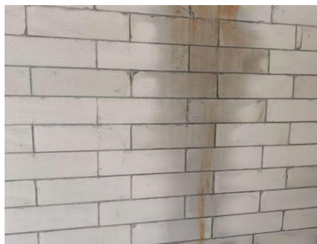
图1.1.1-3 【差】 砌块面出现竖向裂缝、砌块外墙梁下开裂渗漏
