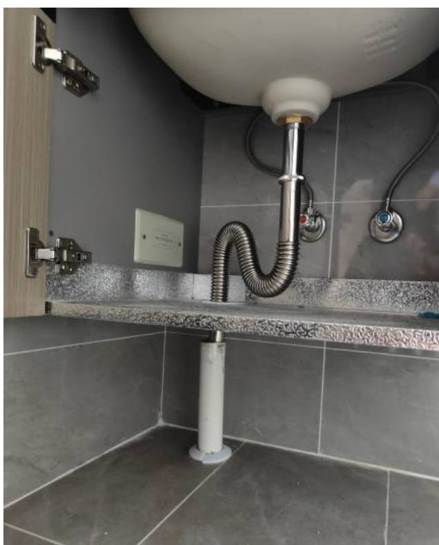
图3.1.6-1 【好】 洗手盆排水管和存水弯（带检修口）安装规范，有效隔断臭味
