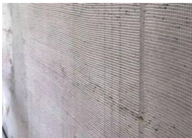
图2.3.2-1 【好】 外墙满挂钢丝网或玻纤网
