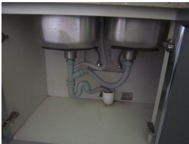
图3.1.5-2 【差】 洗涤盆盆体下方、排水管口持续散发油污腐臭味
