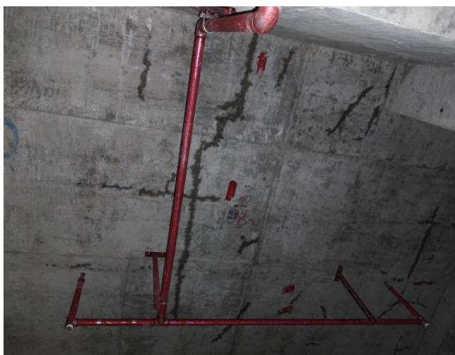
图1.5.4-2 【差】地下室顶板开裂渗漏、地下室顶板开裂渗漏
