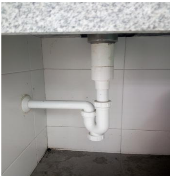
图3.1.6-1 【好】 洗手盆排水管和存水弯（带检修口）安装规范，有效隔断臭味
