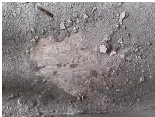
图5.2.1-2 【差】隔声涂料空鼓、开裂
