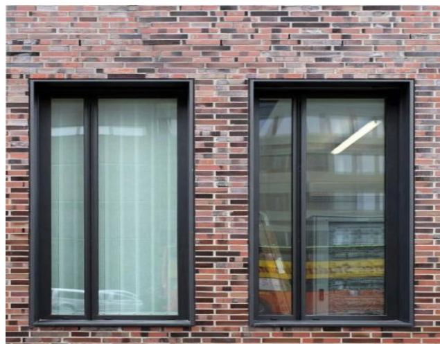
图1.1.1-2 【好】 外墙窗台、门窗洞口无渗漏
