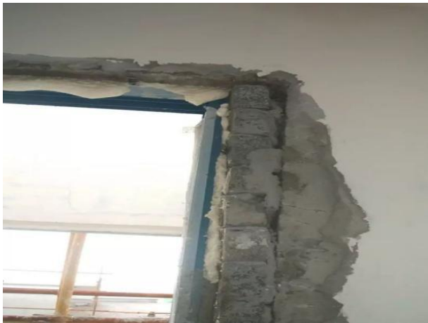
图1.2.1-5 【差】门窗洞口与铝合金门窗缝隙采用砂浆或砌体填塞，容易引起渗漏
