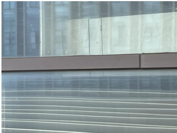
图1.2.2-1 【好】幕墙拼缝使用耐候胶，外观洁净、美观，无空鼓、开裂现象
