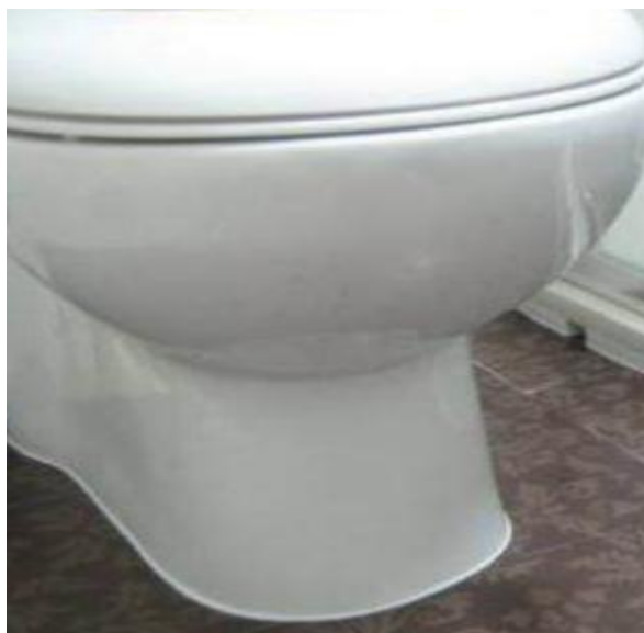
图3.1.4-1 【好】 坐便器底座排污口采用一体化加长法兰，底座与地面打防霉密封处理
