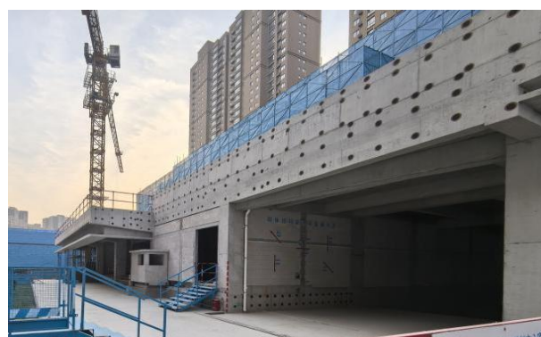
图1.1.2-1 【好】外墙螺栓洞口封堵无渗漏
