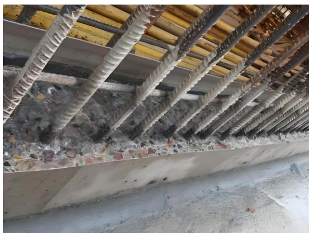
图1.5.2-2 【好】施工缝凿去浮石和浮浆，用水冲洗干净、地下结构侧墙水平施工缝结合紧密，内涂水泥基渗透结晶型防水材料，无渗漏
