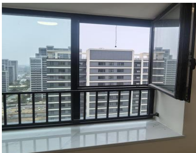
图1.1.1-2 【好】 外墙窗台、门窗洞口无渗漏
