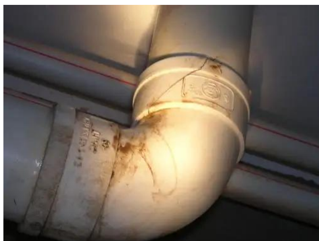
图3.1.1-3 【差】 室内排水管接口出现裂隙，下水道异味沿缝隙窜入室内
