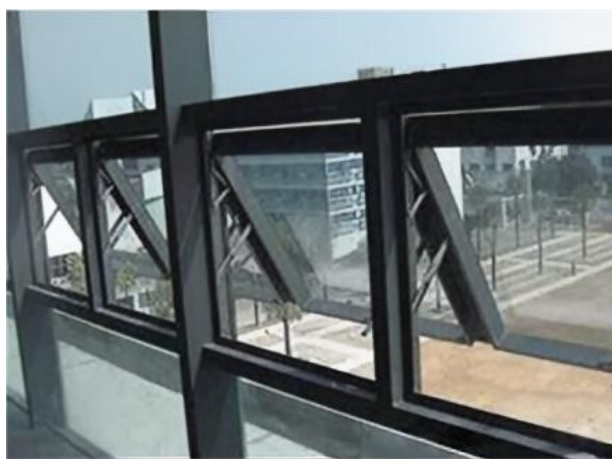
图1.2.2-3 【好】幕墙拼缝使用耐候胶，图1.2.2-4 【好】窗框打胶密实，无渗漏外观洁净、美观，无空鼓
