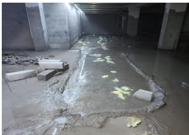
图1.5.1-2 【差】底板防水卷材基层未清理干净，施工未做保护、地下室底板开裂渗漏
