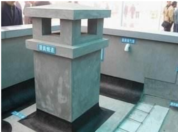
图1.4.3-2 【好】烟道根部防水附加层处理精细
