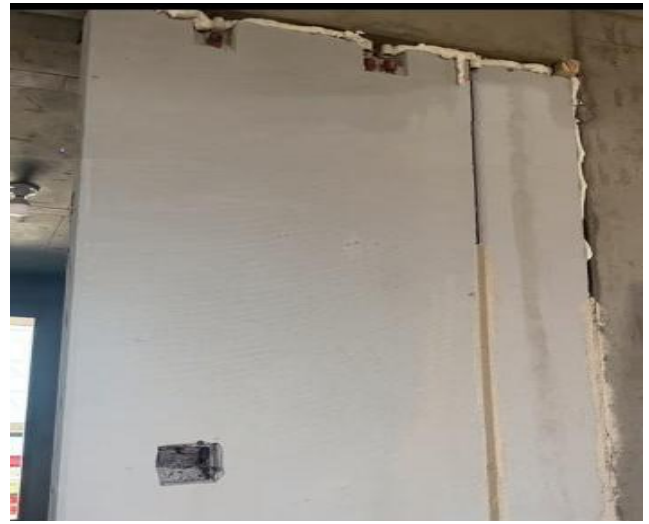
图1.1.6-3 【差】外墙墙板拼缝处渗漏、与钢梁连接处渗漏
