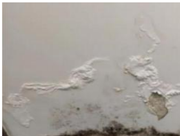
图1. 3. 1-2 【差】墙面返潮、涂料起皮脱落，墙角根部出现黑色霉斑
