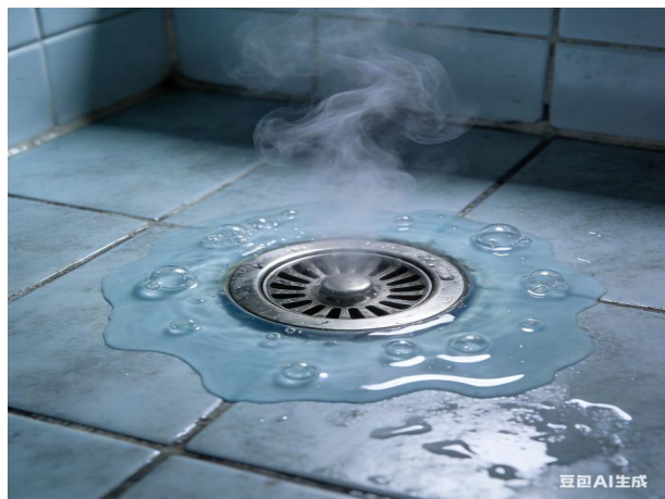
图3.1.2-3 【差】 不带存水弯或存水弯失效的地漏持续散发异味
