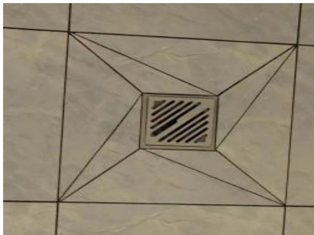
图3.1.2-1 【好】 地漏安装精细，存水弯有效隔断臭味
