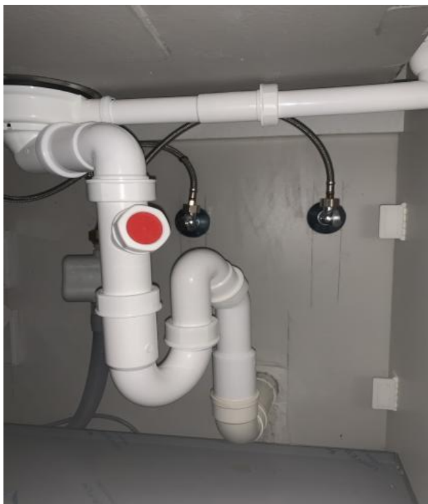
图3.1.5-1 【好】 洗涤盆排水管和存水弯（带检修）安装规范，有效隔断臭味
