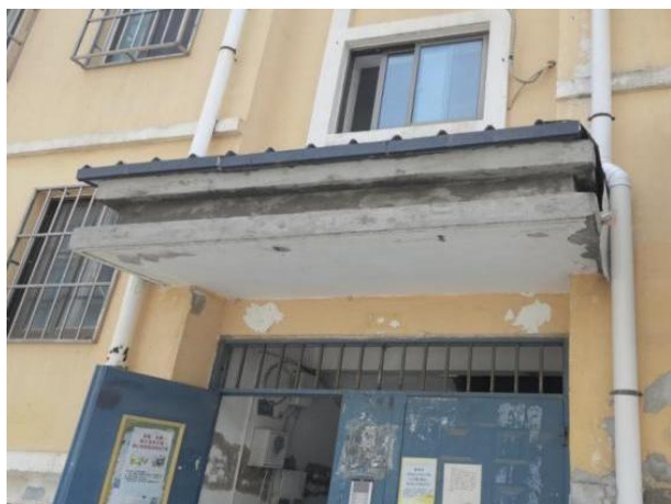
图1.1.7-3 【差】雨篷外找坡坡度不正确, 雨水倒挂
