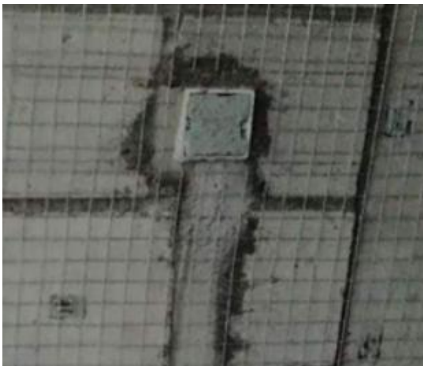
图2.3.5-1 【好】 管线槽处挂网
