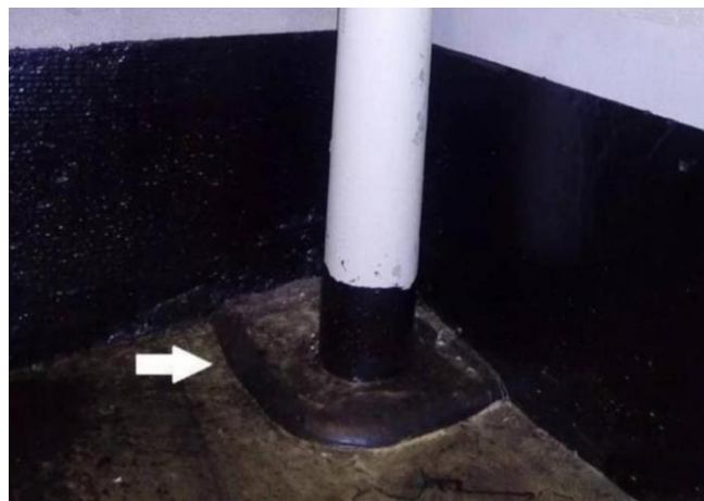
图1. 3. 3-1 【好】厨卫间排水止水节预埋安装定位精准及管道周边防水做法标准
