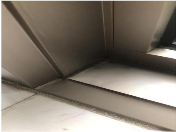
图1.2.1-3 【好】铝合金窗型材接口拼缝严密，无渗漏
