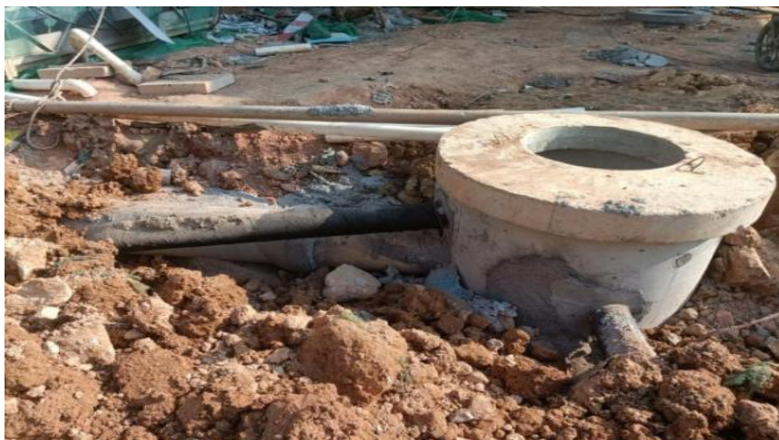
图4.1.1-1【好】室外排水检查井管段高差合理制
