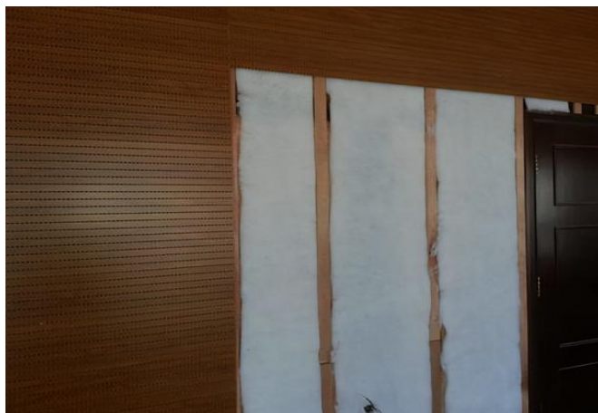
图5.1.2-2 【好】室内隔声墙聚酯 纤维吸音棉
