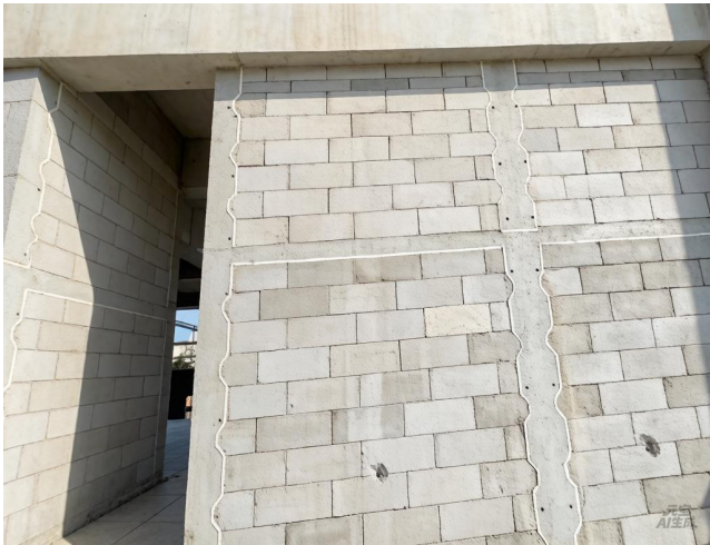
图1.1.1-1 【好】外墙砌体无渗漏
