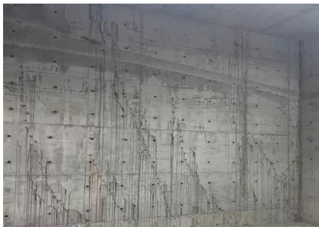
图1.5.2-7 【差】地下室侧墙混凝土施工措施控制不到位，冷缝多、开裂渗漏
