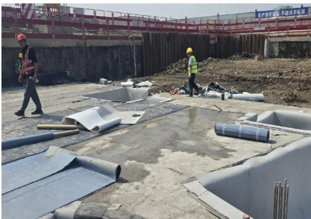
图1.5.1-2 【差】底板防水卷材基层未清理干净，施工未做保护、地下室底板开裂渗漏
