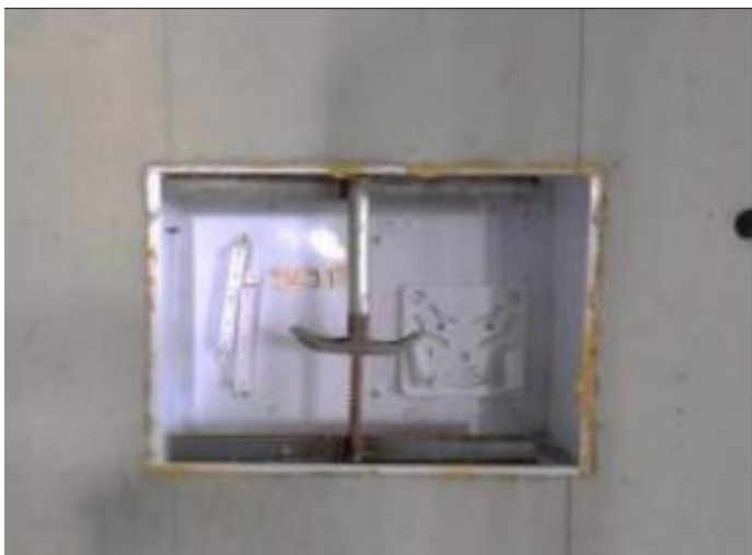
图2.1.6-1 【好】 采用专用开槽机具开槽，成型效果良好；强弱电箱和消防箱ALC墙板预先埋设
