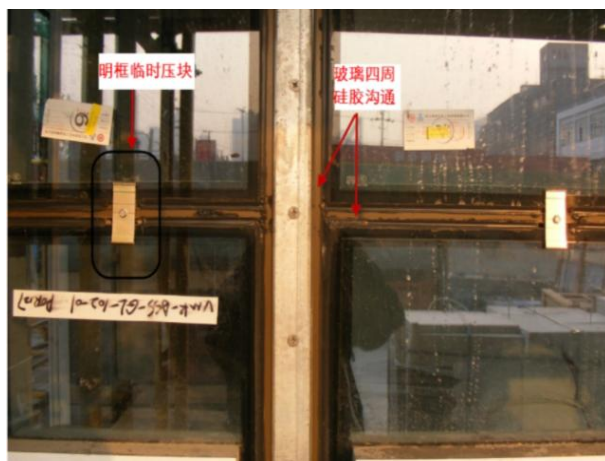
图1.2.2-6 【差】幕墙窗口外侧四周打胶未贯通
