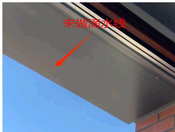
图1.1.7-4 【差】门窗上外口未做滴水线或鹰嘴外找坡坡度不正确
