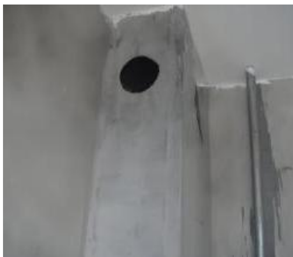
图3.2.1-5 【差】 未安装防火止回阀；
