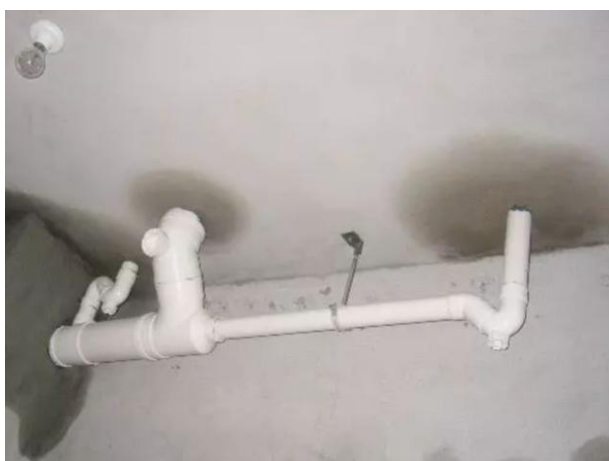
图1. 3. 3-2 【差】管道周边渗漏、发霉
