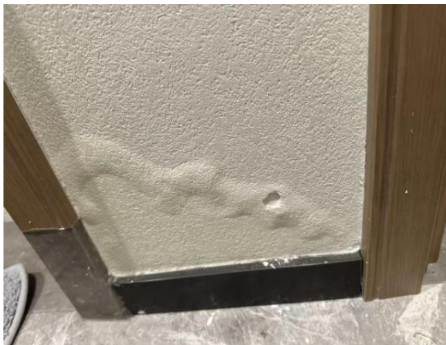
图4.1.3-3 【差】 卫生间沉箱渗漏墙体发霉
