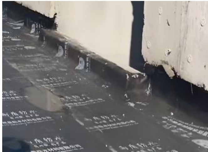
图1.4.7-2 【好】 屋面出入口门槛成型效果
