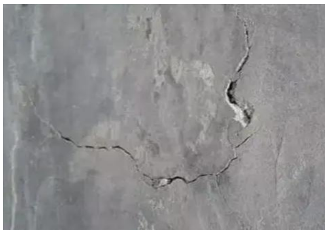
图2.3.2-2 【差】 外墙抹灰层局部开裂
