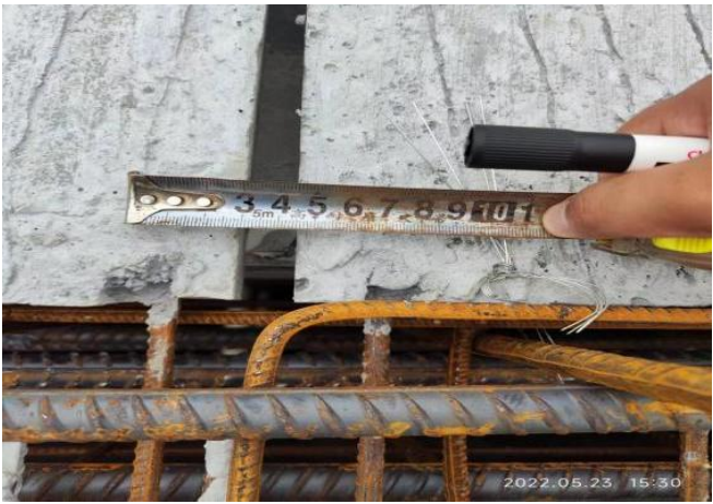
图2.2.3-2 【差】相邻叠合板接缝不严
