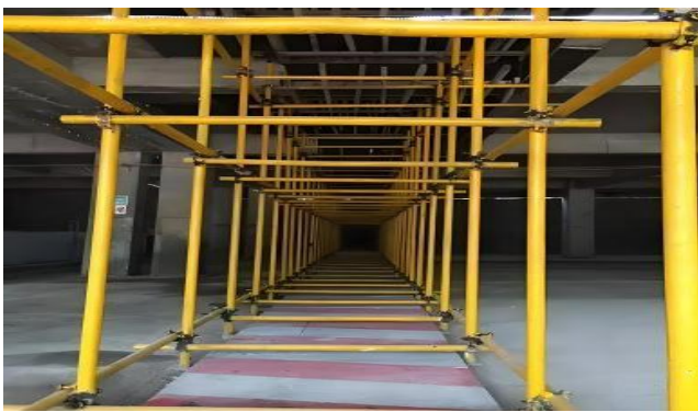
图1.5.3-1 【好】 底板后浇带凿毛、清理到位,无积水、后浇带保护和模架独立搭设
