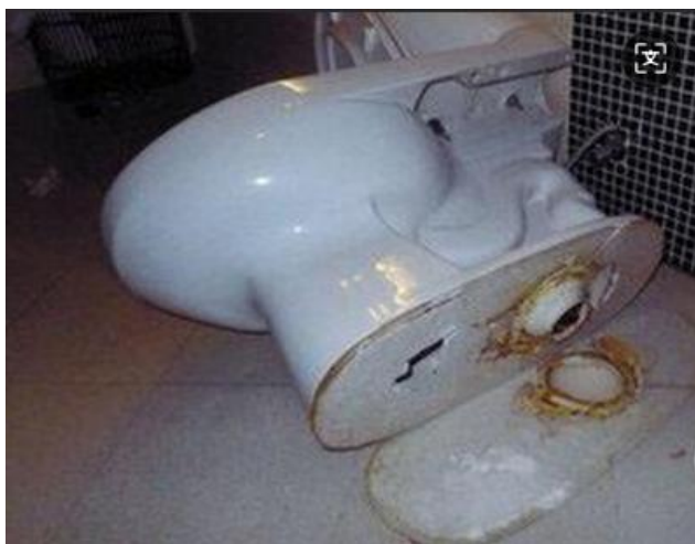
图3.1.4-2 【差】 坐便器底座排污口未使用法兰圈密封导致返臭
