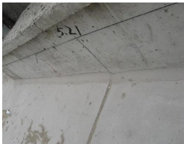
图1.4.2-2 【好】屋面防水施工前 R角处理到位
