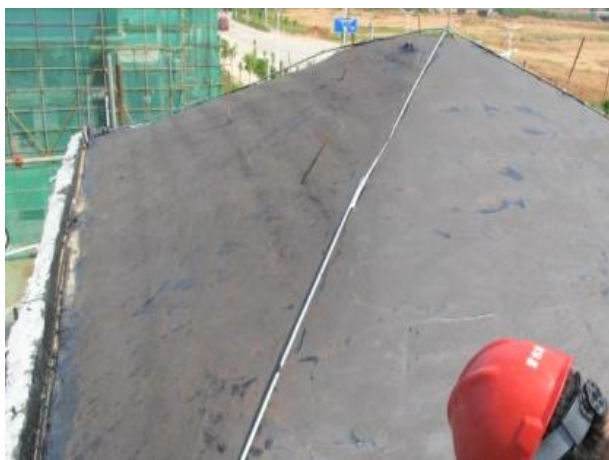
图1.4.2-5 【差】涂膜防水层厚度 不均匀，施工质量
