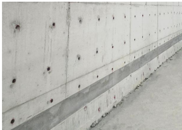
图1.5.2-2 【好】施工缝凿去浮石和浮浆，用水冲洗干净、地下结构侧墙水平施工缝结合紧密，内涂水泥基渗透结晶型防水材料，无渗漏
