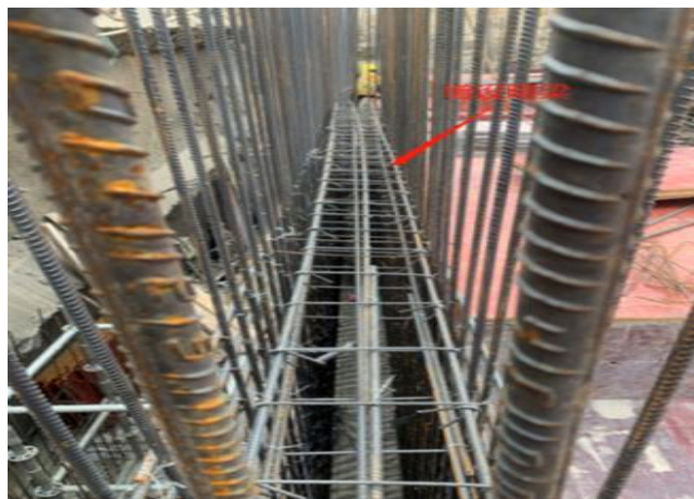
图1.5.2-1 【好】地下室侧墙设置抗裂钢筋网片、地下室外墙设置暗梁
