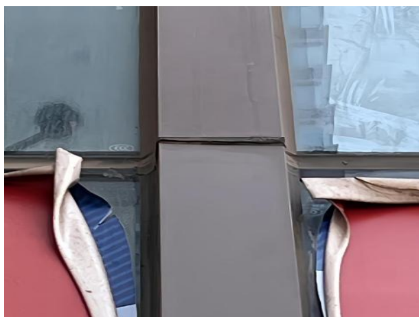
图1.2.2-5 【差】幕墙拼缝有高差，易导致胶开裂
