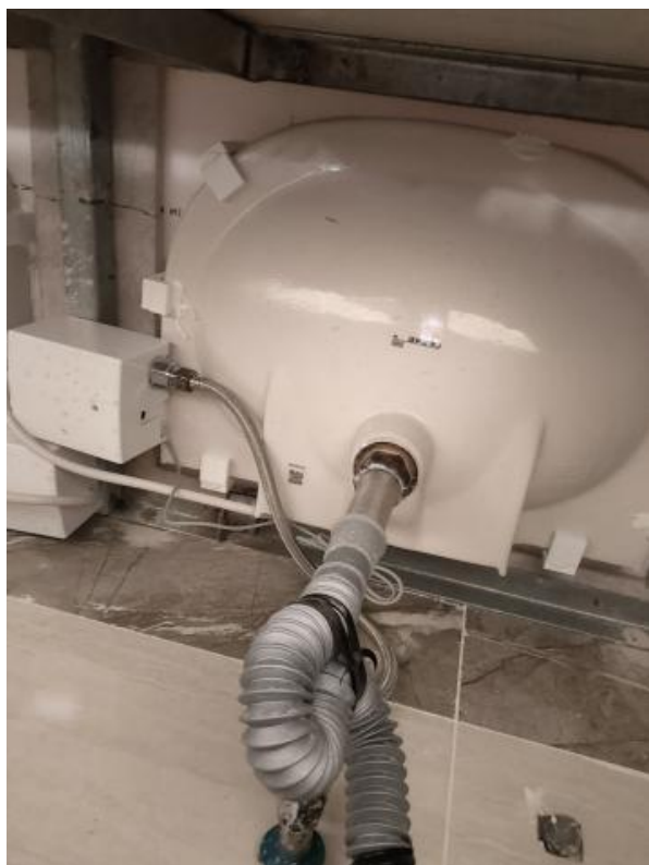
图3.1.6-2 【差】 洗手盆安装不规范，盆口、排水管口散发异味，卫生间洗漱区异味集中
