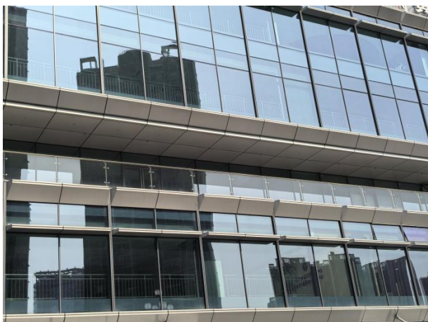
图1.2.2-3 【好】幕墙拼缝使用耐候胶，图1.2.2-4 【好】窗框打胶密实，无渗漏外观洁净、美观，无空鼓
