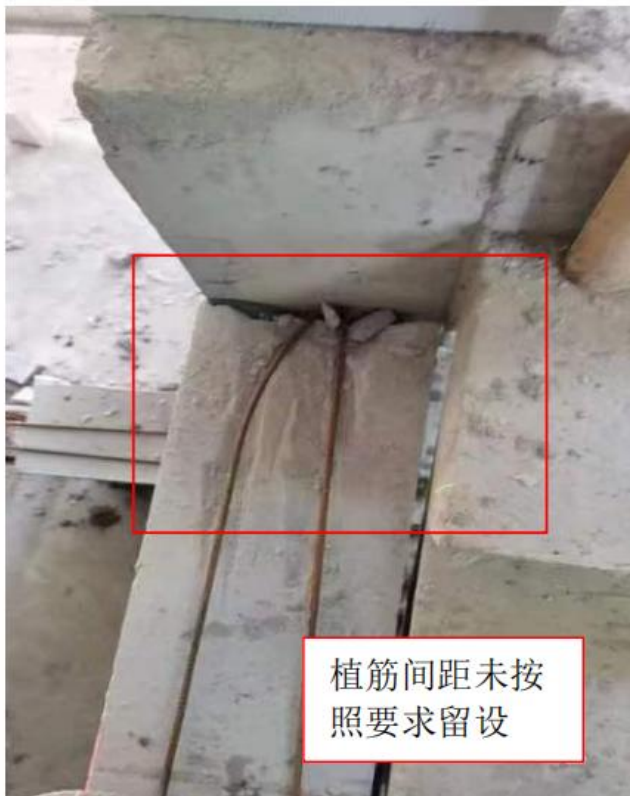
图2.1.2-4 【差】 钢筋水平间距和竖向模数不符合要求；拉结筋长度和水平间距不够、末端未做弯钩
