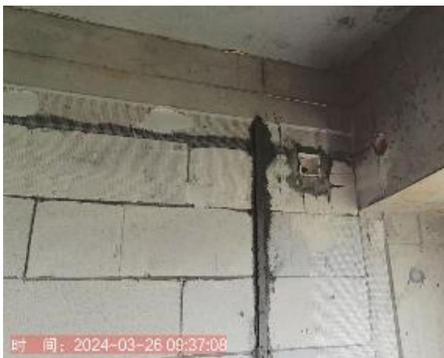
图2.3.4-1 【差】 墙面已冲筋，砌体与混凝土结构交接处挂网缺失
