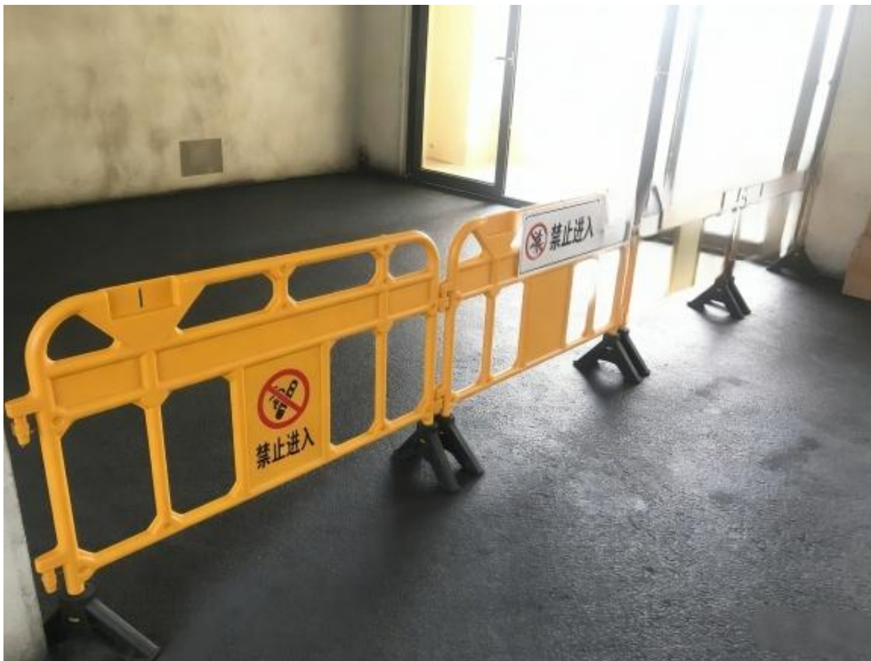
图5.2.1-1 【好】隔声涂料施工完成后门口做防护，禁止踩踏
