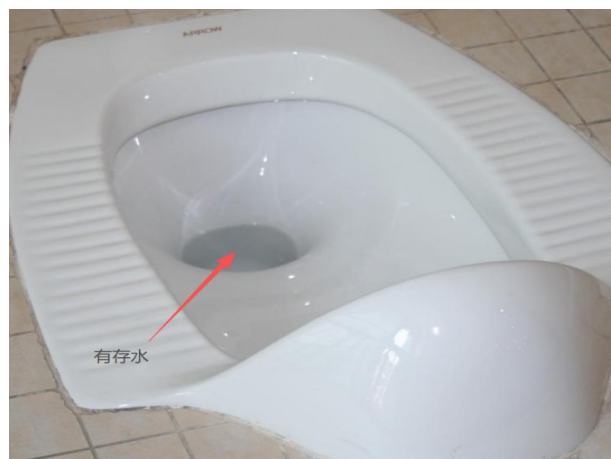
图3.1.3-1 【好】 蹲便器存水弯安装正确，存水弯的存水有效隔断臭味
