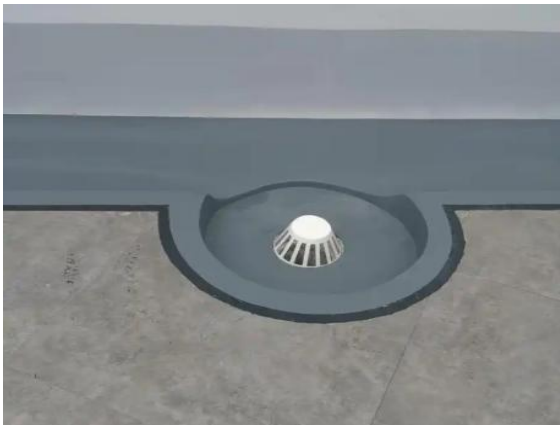
图4.2.3-1 【好】雨水斗排水通畅，标高设置准确
