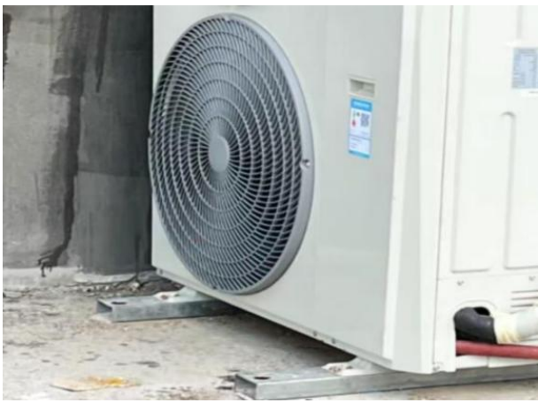
图5. 4. 1-4 【差】顶层及裙楼设备未做减震
