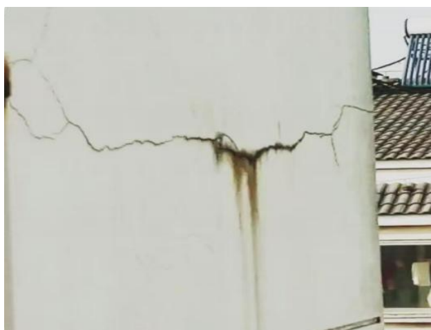
图1.1.1-4 【差】 楼板与墙体交界处水平裂缝、填充墙门窗洞口处开裂渗漏
