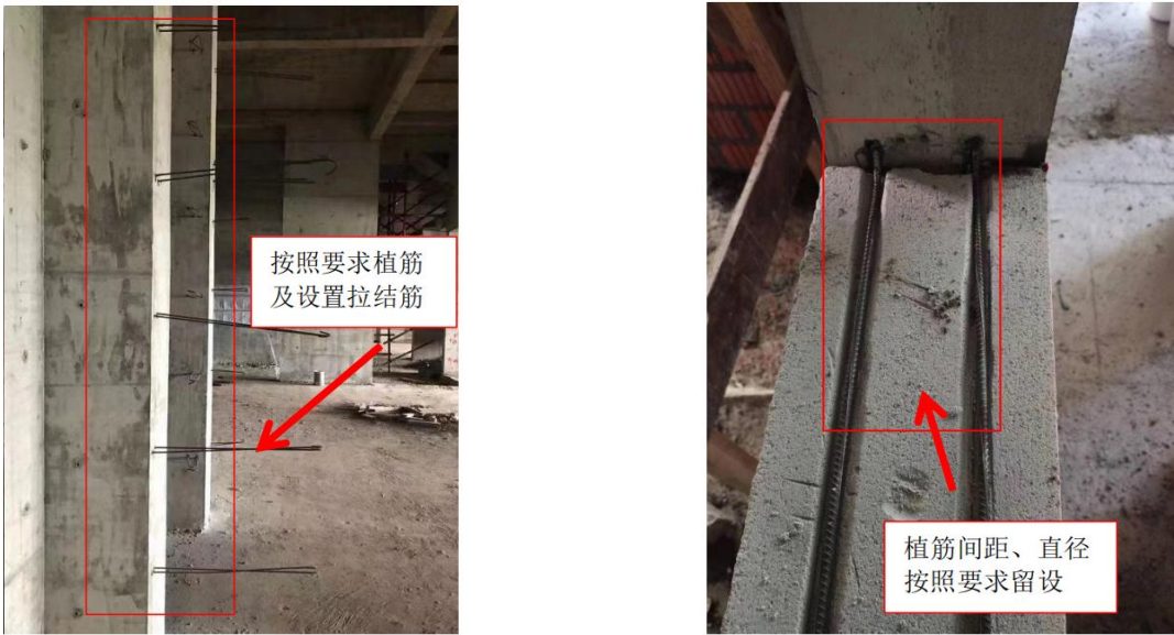
图2.1.2-2 【好】 按照规范要求设置拉结筋；植筋间距、直径按照规范要求留设
