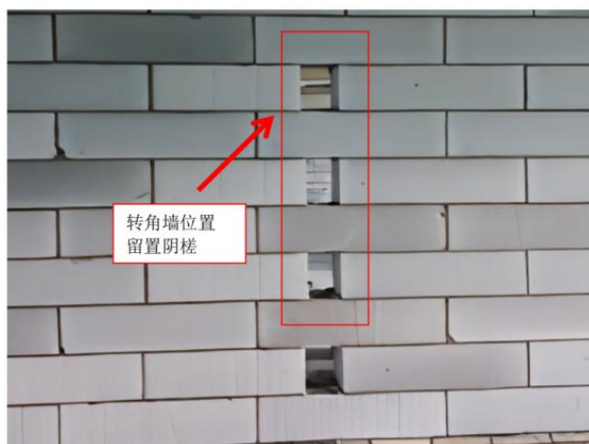
图2.1.3-4 【差】 转角墙位置留置阴槎；转角墙位置留置直槎时，未留置拉结钢筋
