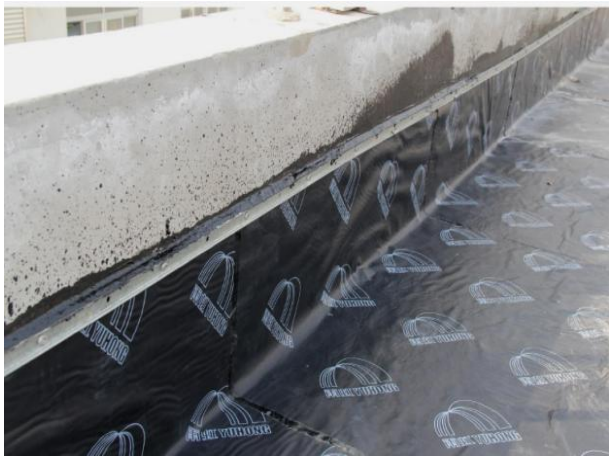
图1.4.1-1 【好】屋面泛水部位防水卷材铺贴平顺，搭接牢固图
