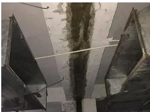
图1.1.5-1 【好】 外墙变形缝无渗漏
