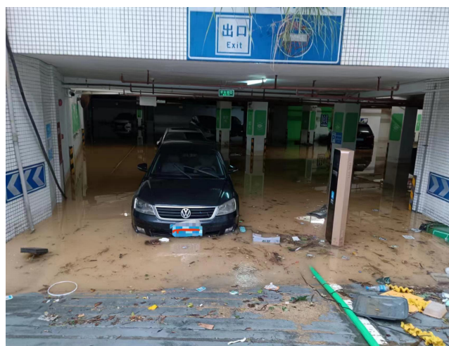
图1.5.5-2 【差】 坡道入口无反坡、截水沟位置错误、雨水倒灌地下车库
