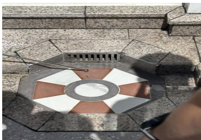
图1.4.4-4 【好】 屋面直排水落口造型美观，无积水渗漏
