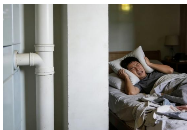
图5.1.2-4 【差】设备井紧邻起居室， 未采用隔声措施
