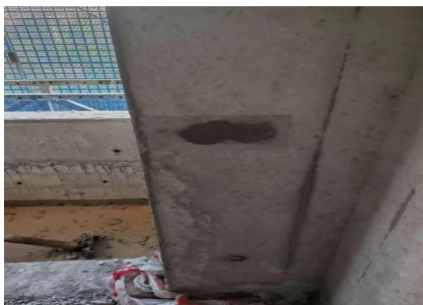
图1.1.2-2 【差】外墙螺栓孔洞处渗漏、外墙固定模板螺栓孔处渗漏
