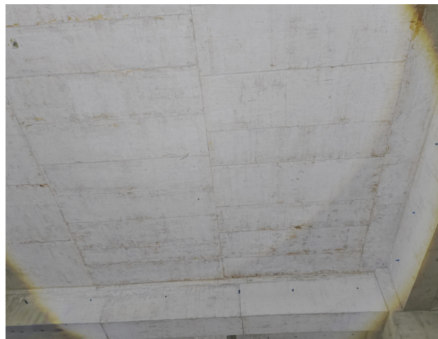
图1.5.4-1 【好】地下室顶板防水卷材铺贴严密、顺直、搭接牢固、顶板混凝土平整、无开裂、无渗漏
