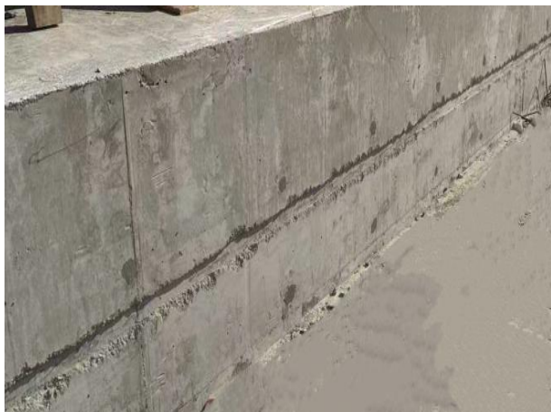
图1.4.6-1 【好】 屋面现浇女儿墙上留置防水卷材收头凹槽
