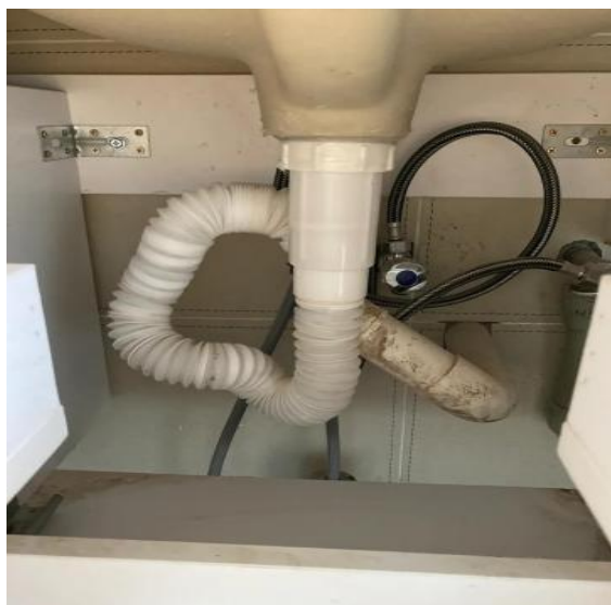
图4.1.2-2 【差】 洗手盆排水管走向复杂
