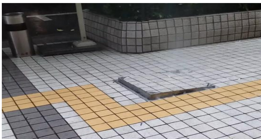
图4.1.1-2【差】超高层屋面雨水势能冲击井盖
