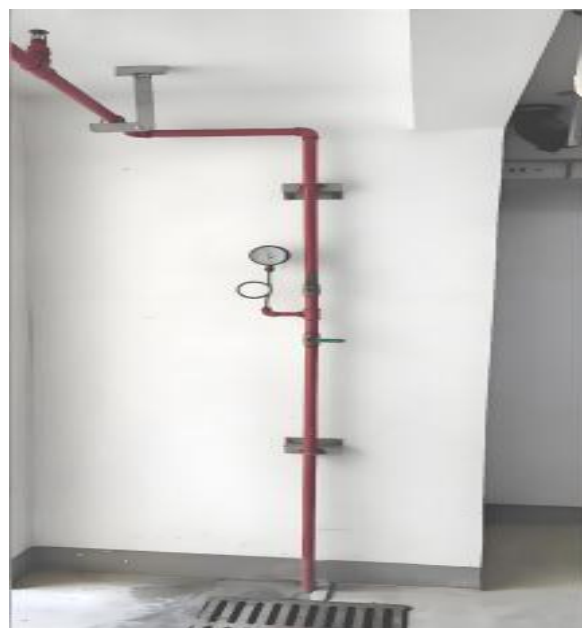
图4.1.4-2 【差】 喷淋试水管未引至集水坑
