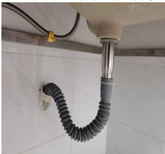
图4.1.2-3 【差】 洗手盆排水管无检修口
