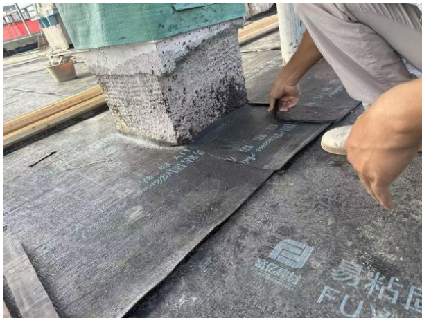
图1.4.3-1 【好】出屋面烟道混凝土反坎随屋面板一次浇筑成型
