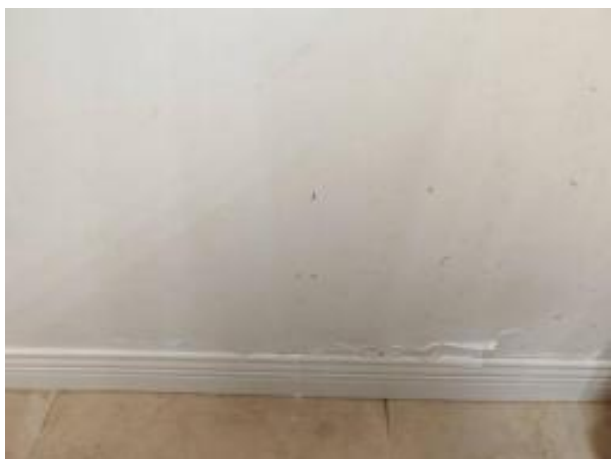
图1. 3. 1-2 【差】墙面返潮、涂料起皮脱落，墙角根部出现黑色霉斑
