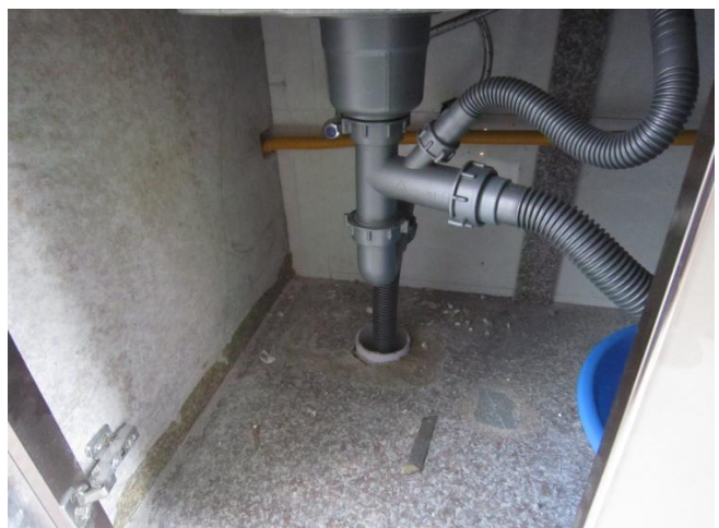
图3.1.5-2 【差】 洗涤盆盆体下方、排水管口持续散发油污腐臭味
