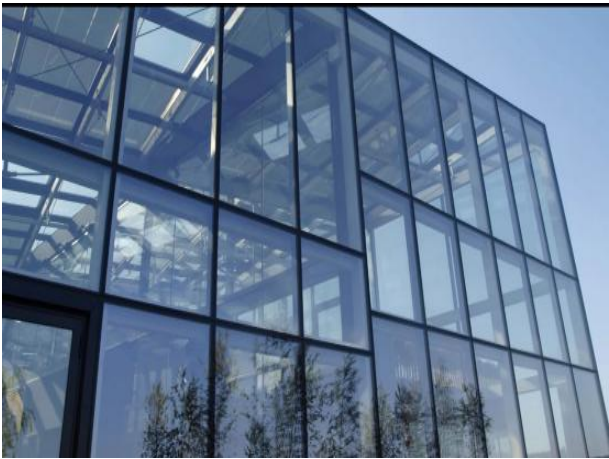
图1.2.2-2 【好】幕墙玻璃框四周打胶饱满、无渗漏
