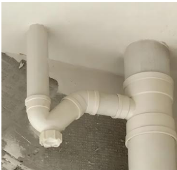
图4.2.2-1 【好】阳台地漏存水弯安装规范
