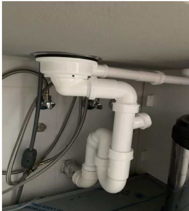
图3.1.5-1 【好】 洗涤盆排水管和存水弯（带检修）安装规范，有效隔断臭味
