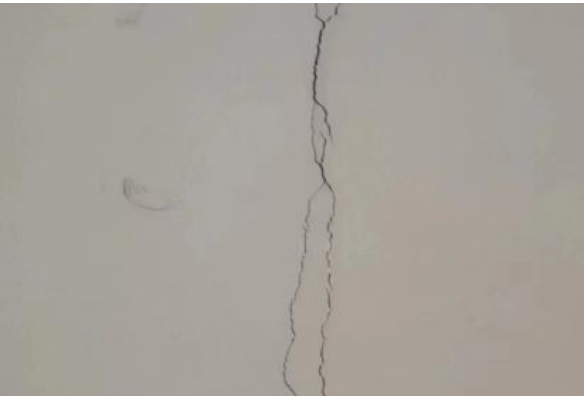
图2.1.5-2 【差】 结构墙与ALC墙板交接处开裂；ALC墙板之间接缝部位开裂
