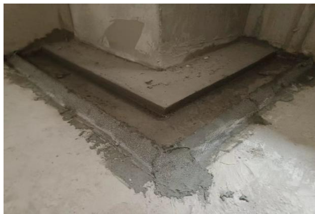
图3.2.1-2 【好】 排烟道吊洞位置设反坎并闭水
