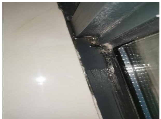
图1.2.1-7 【差】铝合金窗型材接口拼缝不严密、窗框四周塞缝不严密，渗漏
