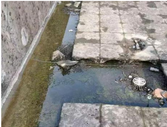
图4.2.3-3 【差】屋面雨水斗杂物堆积，导致堵塞
