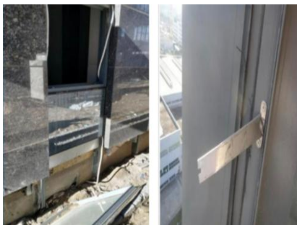
图1.2.2-8 【差】幕墙玻璃板块底部未设置金属托条，加固不到位
