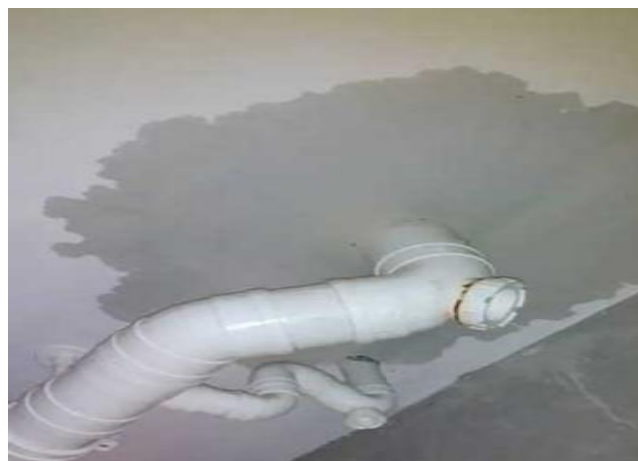
图1. 3. 3-2 【差】管道周边渗漏、发霉
