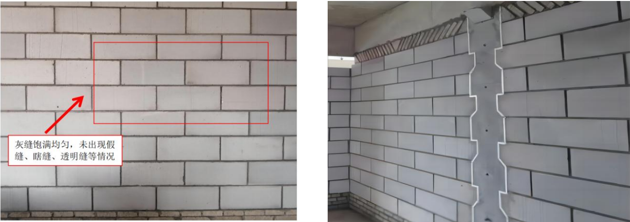
图2.1.3-3 【好】 灰缝饱满均匀；未出现假缝、瞎缝、透明缝等情况
