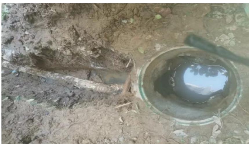
图4.1.1-3【差】排水管道变形倒坡，积水明显
