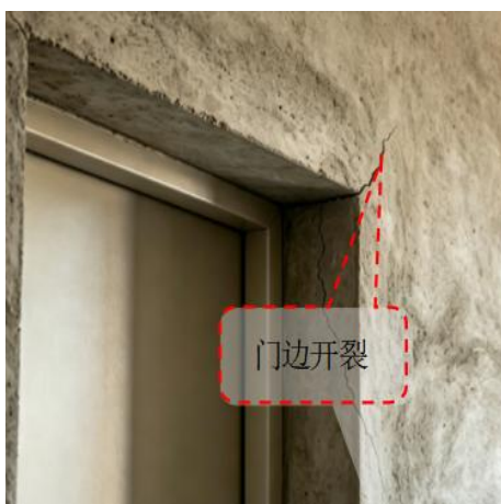
图2.1.1-2 【差】 混凝土门边开裂；填充墙窗洞口开裂示例(供参考)
