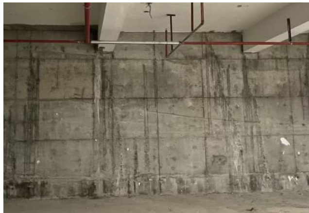
图1.5.2-7 【差】地下室侧墙混凝土施工措施控制不到位，冷缝多、开裂渗漏
