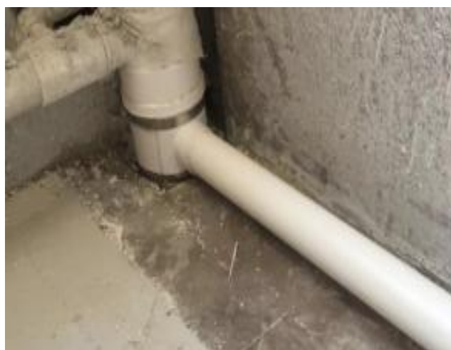
图3.1.1-4 【差】 支管与立管采用直角三通连接，水流对冲产生涡流，破坏支管水封，异味反窜入室内
