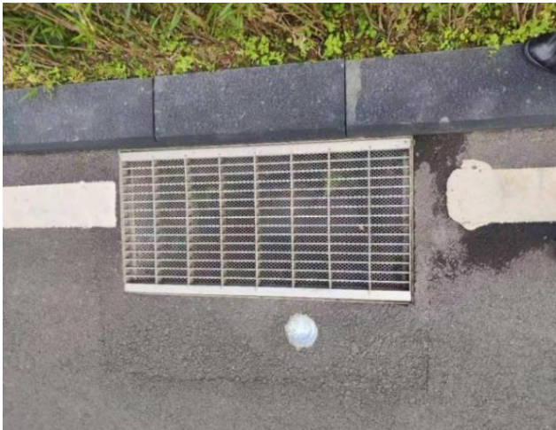
图4.1.6-2 【好】 水沟滤网有效隔阻 树叶与杂物
