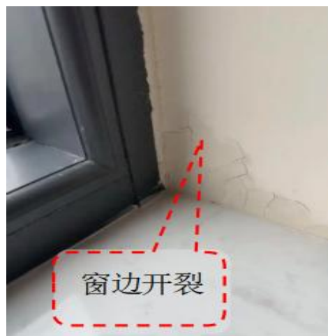
图2.1.1-2 【差】 混凝土门边开裂；填充墙窗洞口开裂示例(供参考)
