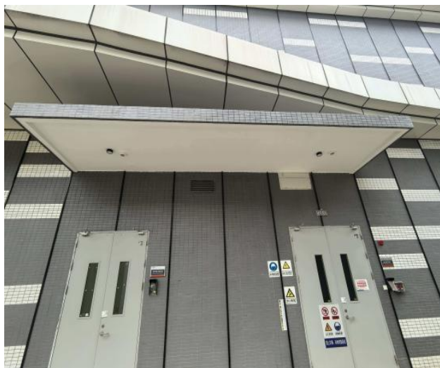
图1.1.3-1 【好】雨篷根部无渗漏
