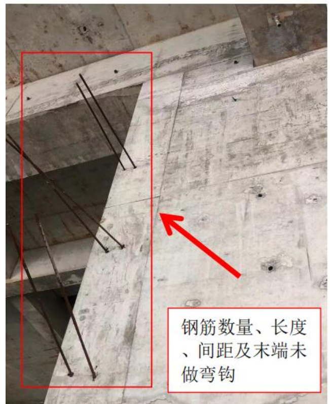
图2.1.2-4 【差】 钢筋水平间距和竖向模数不符合要求；拉结筋长度和水平间距不够、末端未做弯钩
