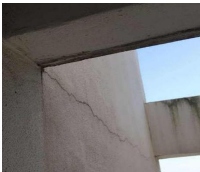
图2.3.2-3 【差】 外墙抹灰层出现线性裂缝
