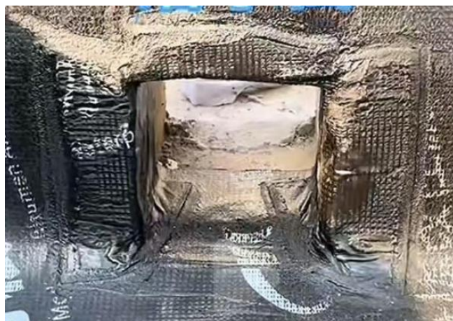
图1.4.4-2 【好】 屋面侧排水落口防水卷材严密
