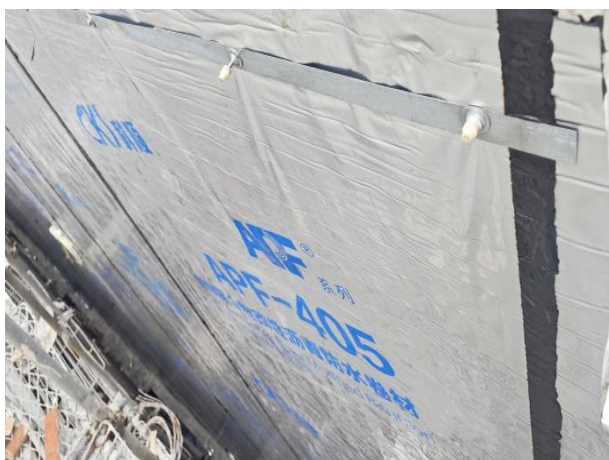
图1.5.2-3 【好】地下室侧墙卷材铺贴顺直、搭接合理、固定稳固、地下室侧墙混凝土无裂缝、渗漏，螺杆孔封堵标准
