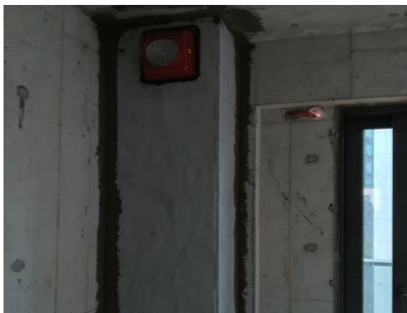
图3.2.1-3 【好】 排烟道外壁缝隙加强处理
