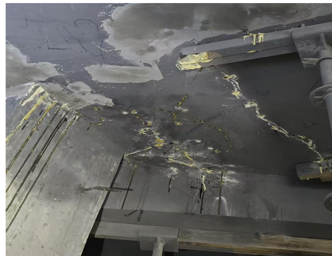
图1.5.4-2 【差】地下室顶板开裂渗漏、地下室顶板开裂渗漏
