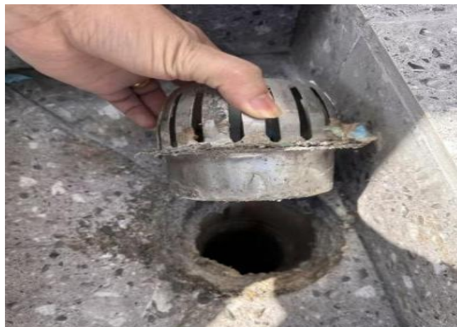
图1.4.4-6 【差】 屋面水落口周边渗漏积水
