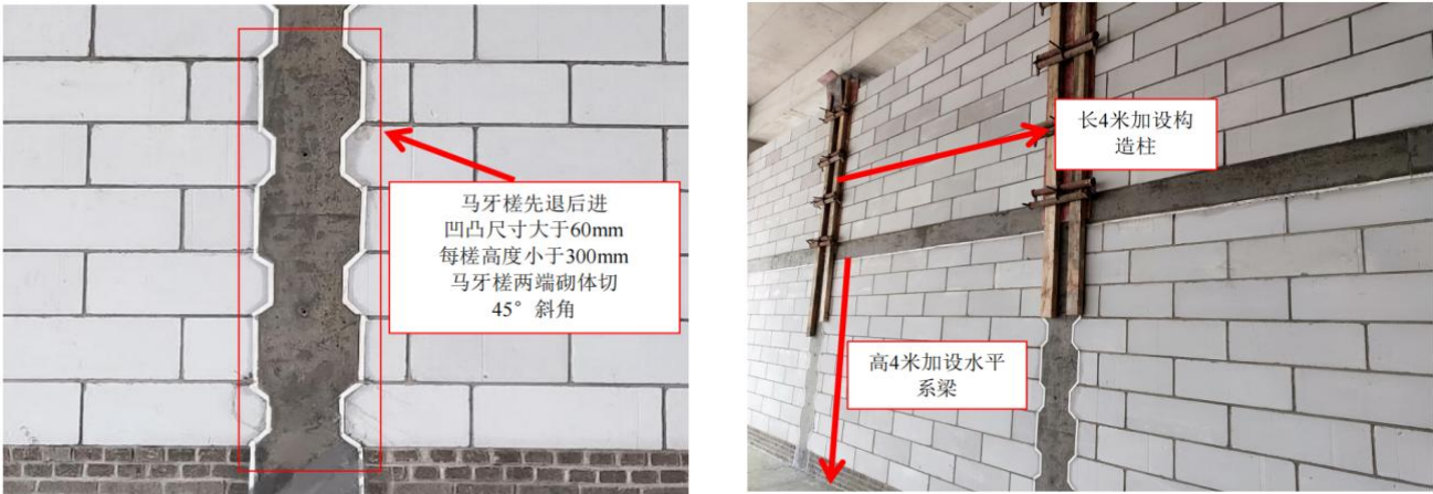
图2.1.3-2 【好】 构造柱马牙槎设置规范; 长超4m加设构造柱、高超4m加设水平系梁
