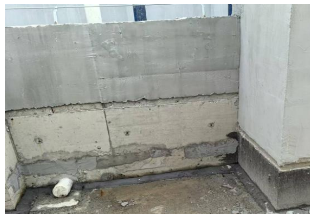
图1.1.2-2 【差】外墙螺栓孔洞处渗漏、外墙固定模板螺栓孔处渗漏
