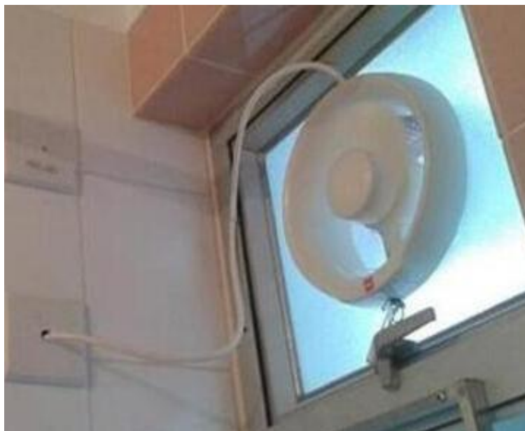
图3.2.2-2 【差】 排气扇无止回阀
