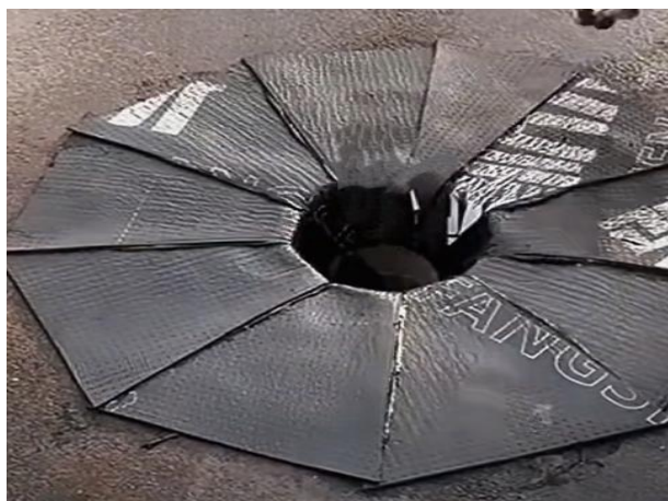
图1.4.4-1 【好】 屋面直排水落口防水附加层铺贴铺贴严密
