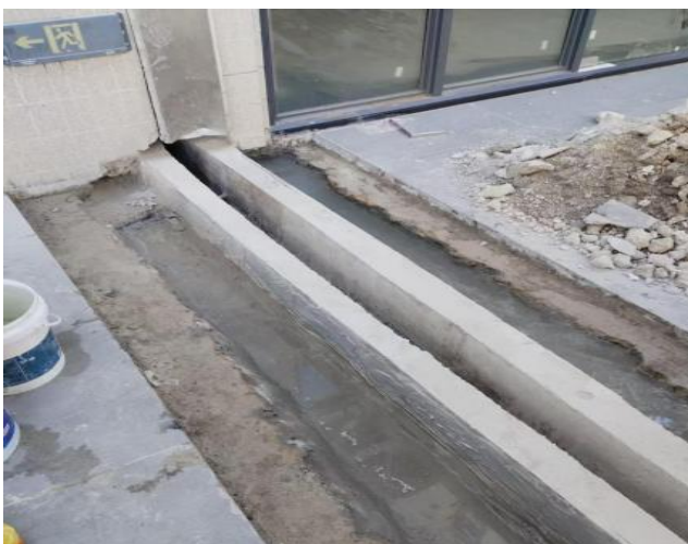
图1.4.5-3 【差】屋面变形缝发生拉裂、渗水
