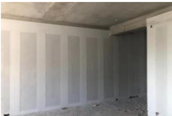
图2.1.5-1 【好】 ALC墙板成型质量观感良好；墙板交接处挂网补缝、成型效果平整、无开裂
