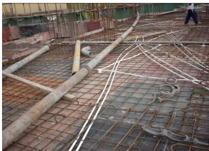
图2.2.1-3 【差】混凝土输送管压沉楼面钢筋
