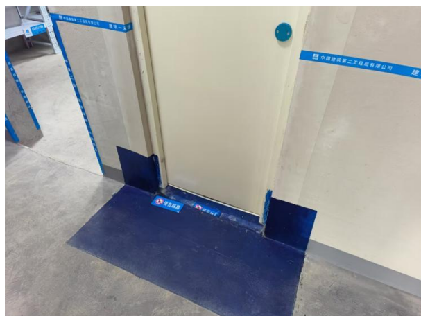
图1. 3. 1-1 【好】卫生间各部位防水施工涂刷均匀、施工规范
