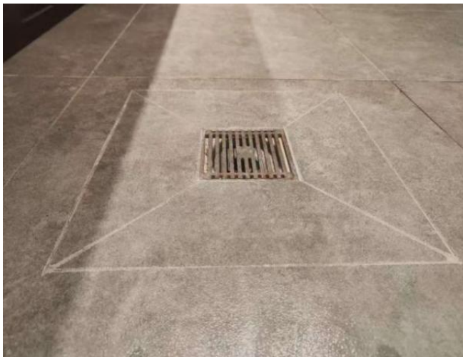
图4.1.3-1 【好】 地漏四周导坡良好，水顺畅
