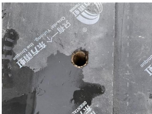
图1.4.4-5 【差】 屋面水落口防水卷材施工不规范
