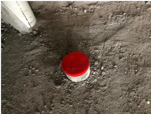
图4. 2. 4-1 【好】装修阶段地漏连接管成品保护措施到位
