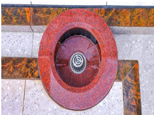
图1.4.4-3 【好】 屋面侧排水落口造型美观，无积水渗漏
