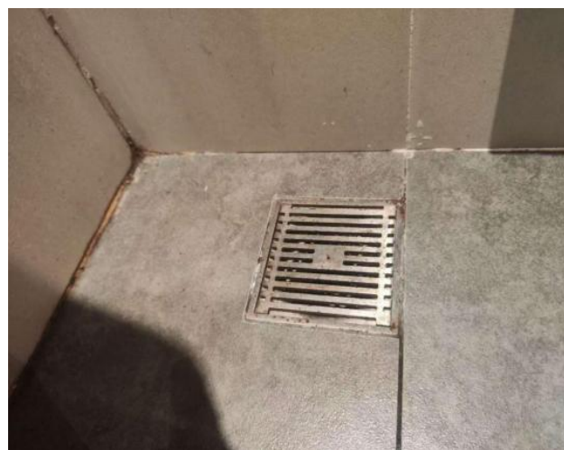
图4.1.3-4 【差】 地漏周边无找坡，致排水不畅
