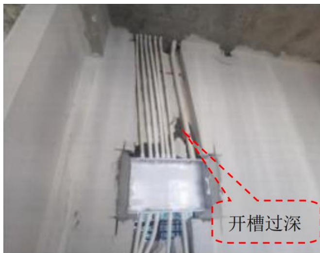
图2.1.6-2 【差】 线管后开孔洞打凿随意；线管开槽过深
