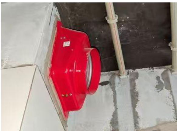
图3.2.1-1 【好】 排烟道口安装防火止回阀
