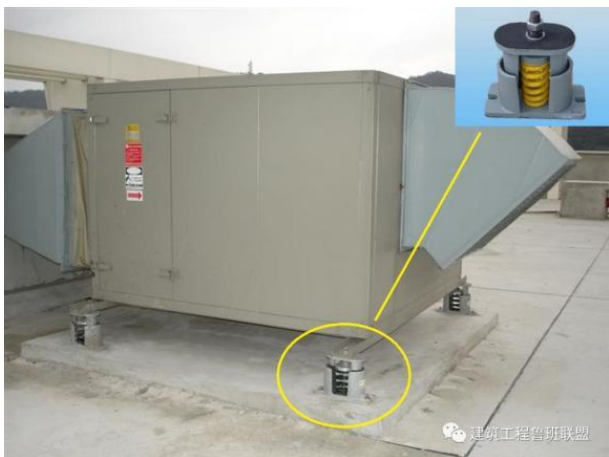
图5. 4. 1-2 【好】设备安装弹簧减振
