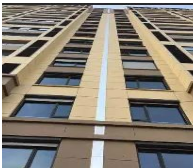
图1.1.5-1 【好】 外墙变形缝无渗漏
