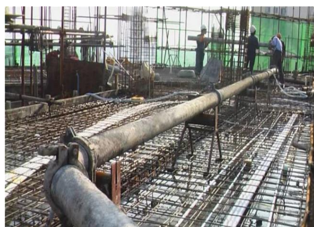
图2.2.1-2 【好】避免泵送混凝土送管对钢筋骨架的重压及振动
