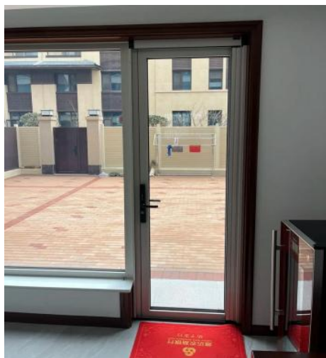
图2.1.1-1 【好】 门洞留设合理，成型效果好；窗塞缝密实，施工质量良好
