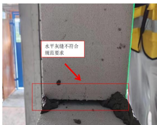
图2.1.3-6 【差】 砂浆饱满度不足，出现透明缝；水平灰缝不符合规范要求
