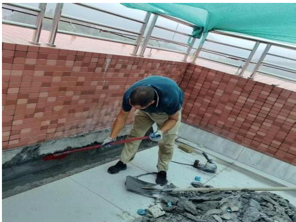
图1.4.1-4 【差】屋面泛水部位渗漏积水
