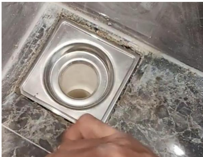
图4.2.1-1 【好】 厕浴地漏与管道连接对中, 无错位
