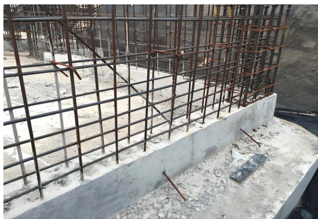
图1.5.2-6 【差】 地下室侧墙施工缝漏设止水钢板、凿毛处理不到位、地下室侧墙渗漏水
