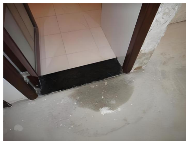
图1. 3. 5-4 【差】门槛石下渗漏
