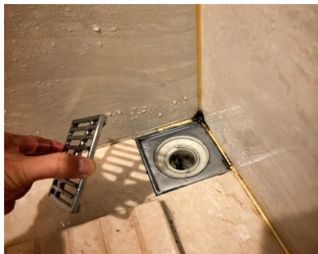
图4.2.1-4 【差】 厕浴地漏未安装配套毛发过滤网导致堵塞
