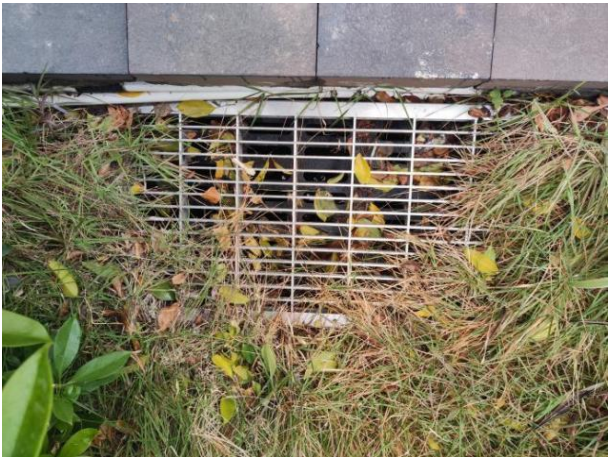
图4.1.6-3 【差】 雨水沟杂物堵塞
