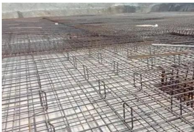
图2.2.1-1 【好】成品马镫有效保证上部负弯矩钢筋不变形输
