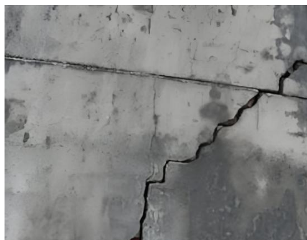
图1.1.1-4 【差】 楼板与墙体交界处水平裂缝、填充墙门窗洞口处开裂渗漏
