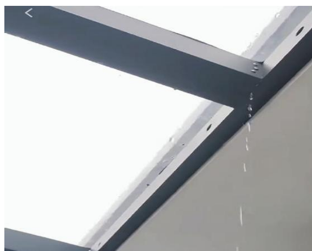
图1.1.3-2 【差】雨篷根部混凝土结构开裂产生渗漏、雨篷根部积水渗漏
