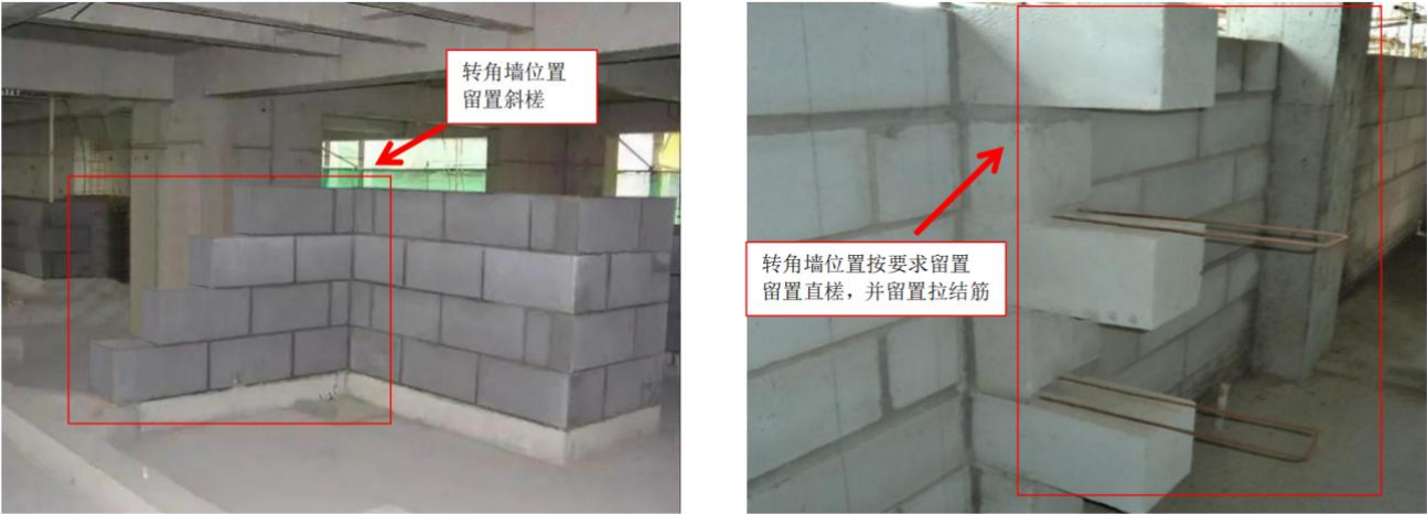
图2.1.3-1 【好】 转角墙位置按要求留置斜槎；转角墙位置按要求留置直槎，并留置拉结筋
