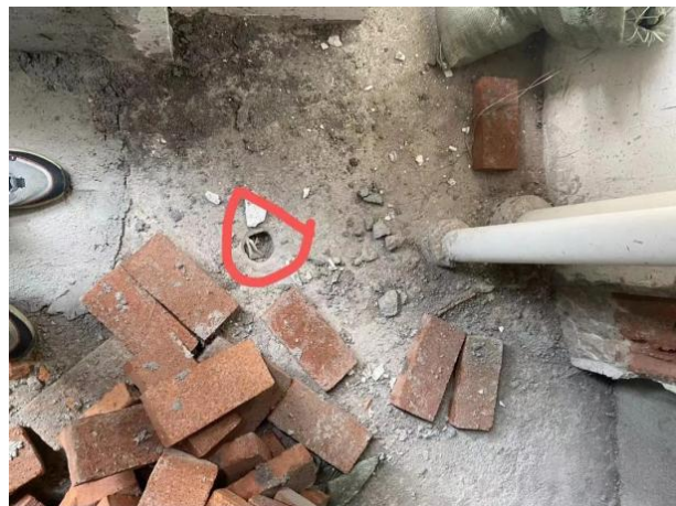
图4. 2. 4-2 【差】装修阶段半成品保护不到位导致地漏预留管堵塞
