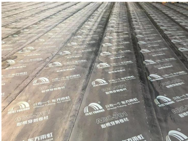
图1.5.4-1 【好】地下室顶板防水卷材铺贴严密、顺直、搭接牢固、顶板混凝土平整、无开裂、无渗漏
