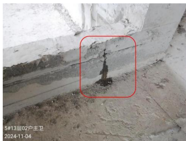
图1. 3. 5-3 【差】卫反坎渗漏
