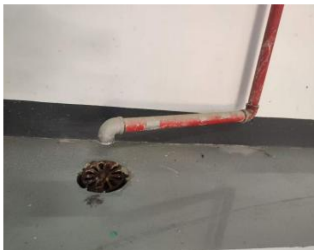
图4.1.4-3 【差】 喷淋试水排水易渗漏
