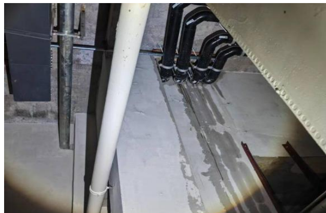
图1.5.2-8 【差】防水卷材未卷入预埋套管内，防水保护不到位、侧壁穿墙管道渗漏水
