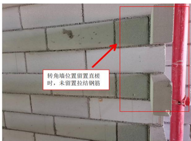
图2.1.3-4 【差】 转角墙位置留置阴槎；转角墙位置留置直槎时，未留置拉结钢筋
