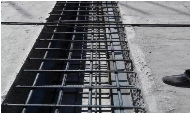
图1.5.3-1 【好】 底板后浇带凿毛、清理到位,无积水、后浇带保护和模架独立搭设
