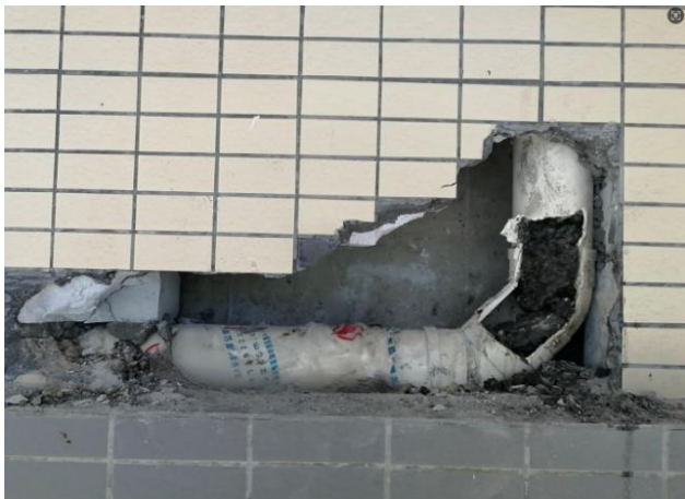
图4.1.6-3 【差】 排水管内垃圾砂浆淤积
