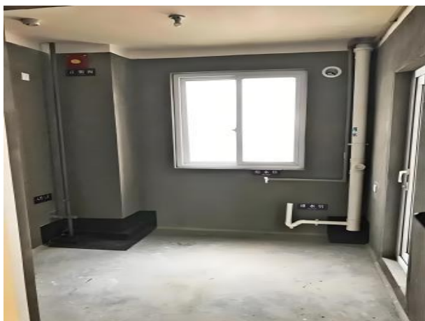
图1.3.2-3 【差】墙面返潮、涂料起皮脱落，墙角根部出现黑色霉斑
