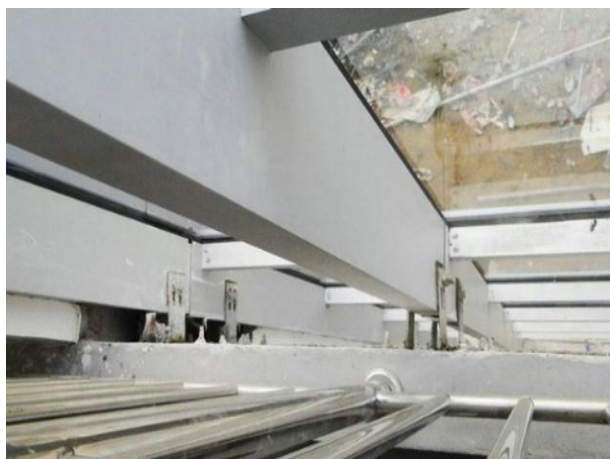
图 5.3.2-3 【差】幕墙缝隙未做隔声处理
