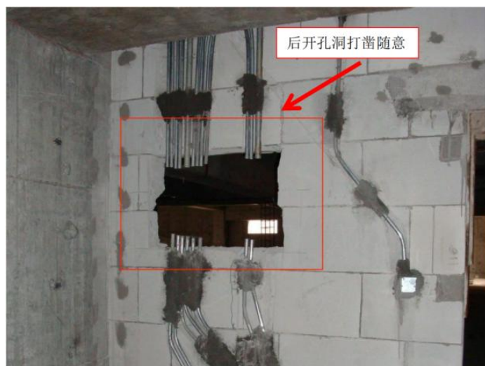
图2.1.6-2 【差】 线管后开孔洞打凿随意；线管开槽过深
