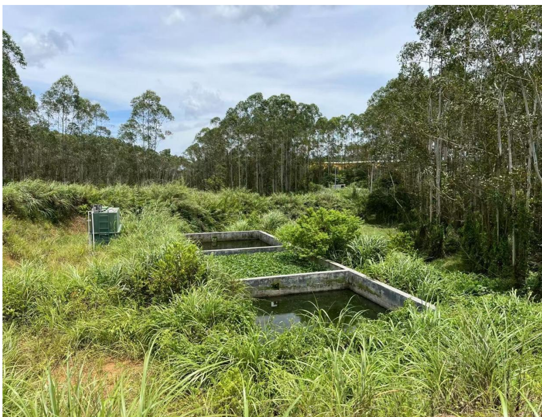
图 3.4-1 污水处理设施照片
