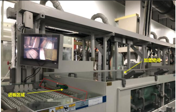
水平线加盖密闭收集
