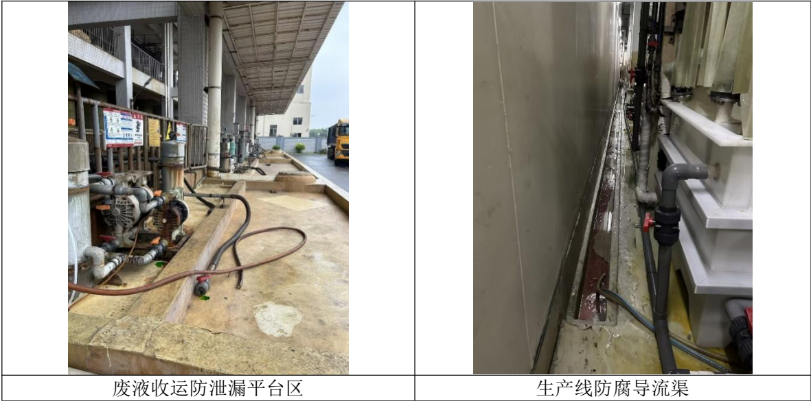
图 3.7-2 地表水、地下水污染风险防控措施
