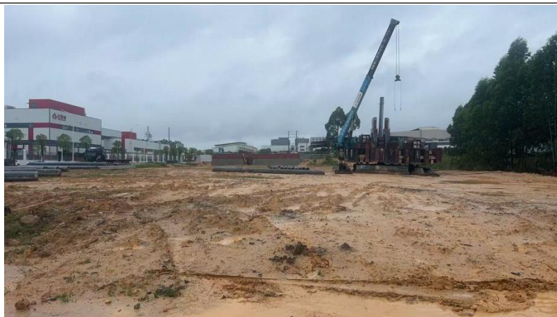
项目西侧（在建工地）
