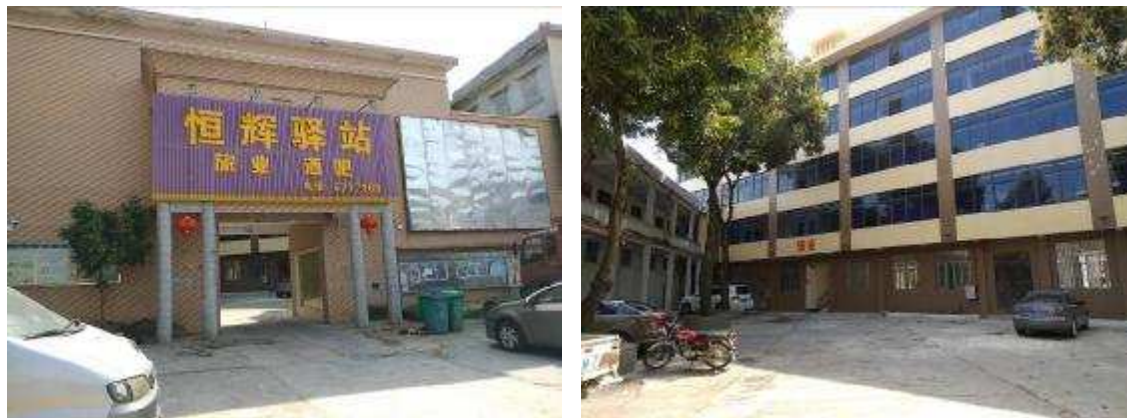
临时施工营地改造为旅馆
