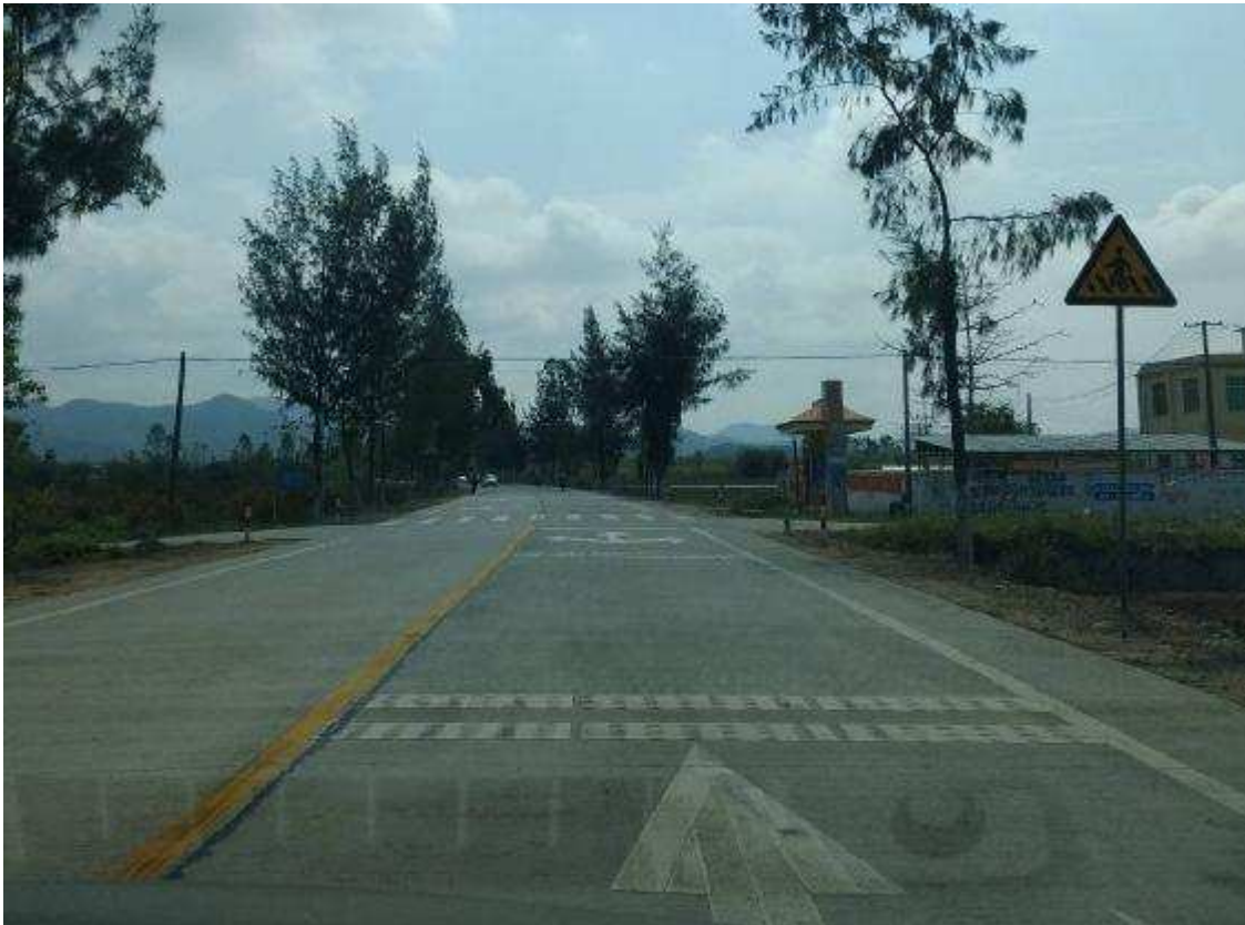
图 10.4 公路沿线斑马线及提示牌
