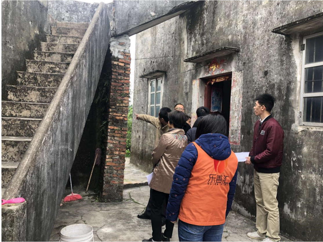
▲ 督导组现场检查罗坑村贫困户黎桂婵住房情况
