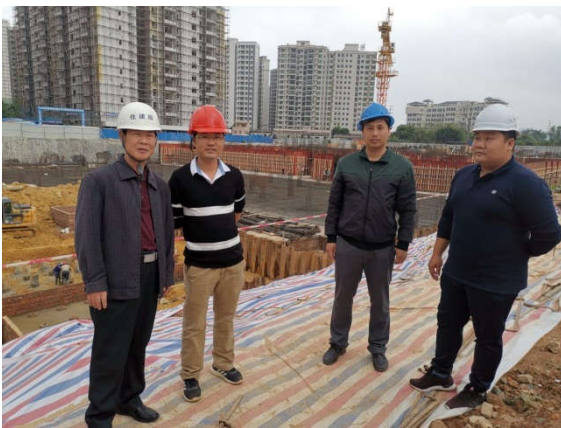
台山市住建局检查锦绣花园项目
