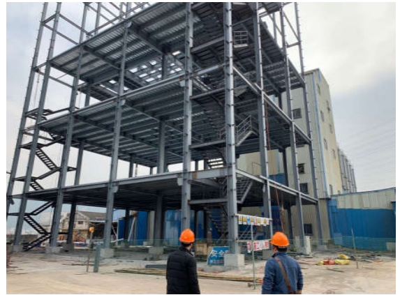
新会区住建局检查普惠饲料厂车间一项目
